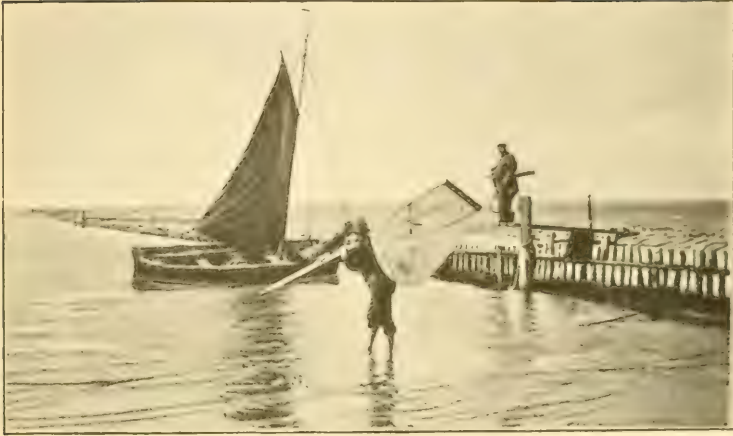
Die grosse südwestliche Buhne mit dem Anlegeplatze.
