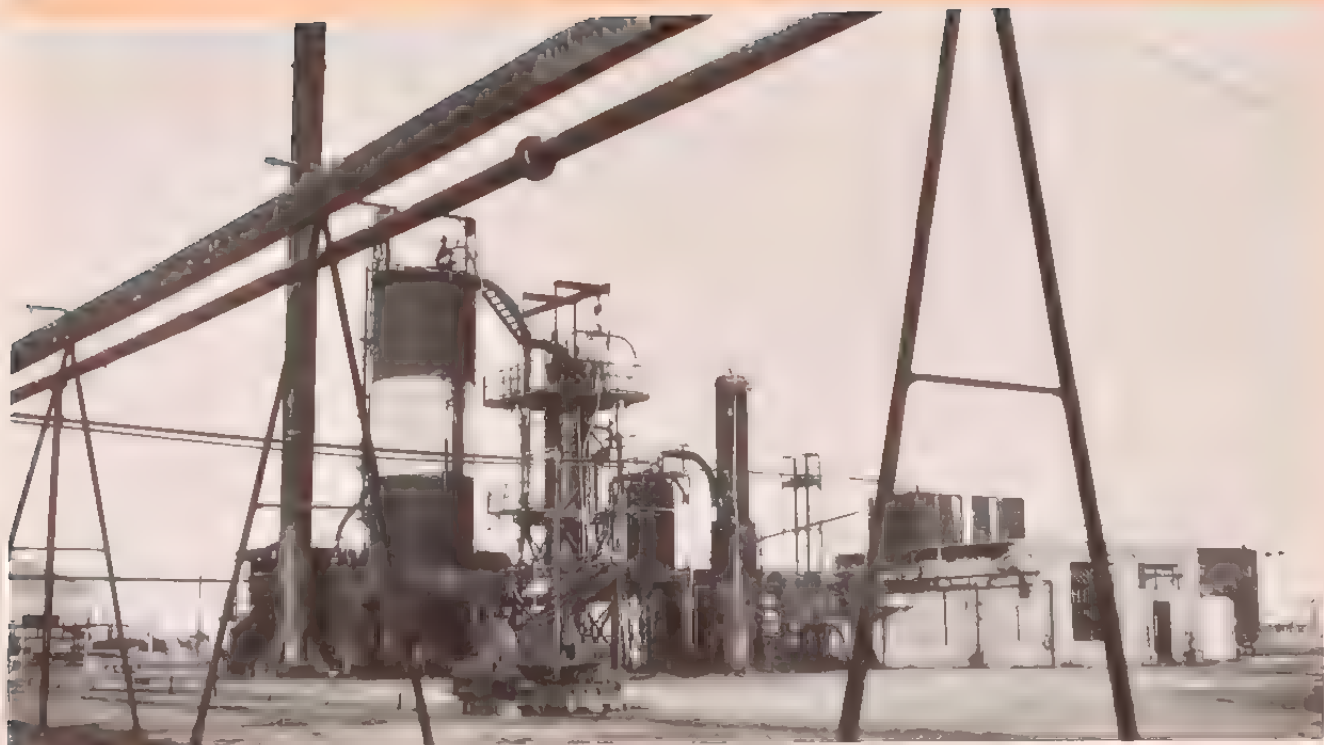
Planta de cracking.
