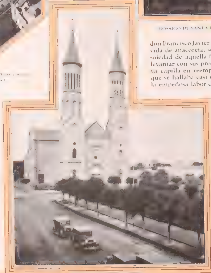
IGLESIA MATRIZ DE SANTA FE — Vista desde el cerro de Tepeyac
