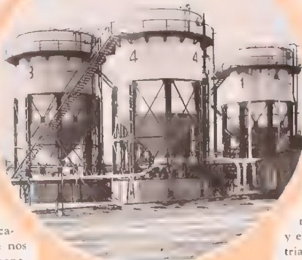
Aspecto parcial de la refinería que muestra el grupo de depósitos para el refinamiento de los productos.
