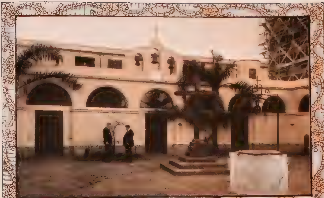
Vista interior del patio de la Casa de Ejercicios
