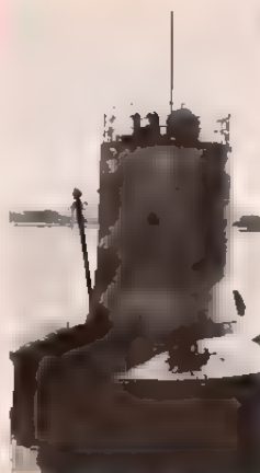
La torre de amarre notable obra de ingeniería
