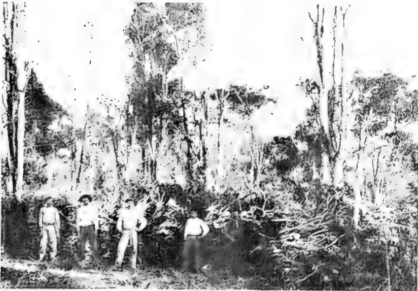
Fig. 2. — Trabajos empezando el trabajo
