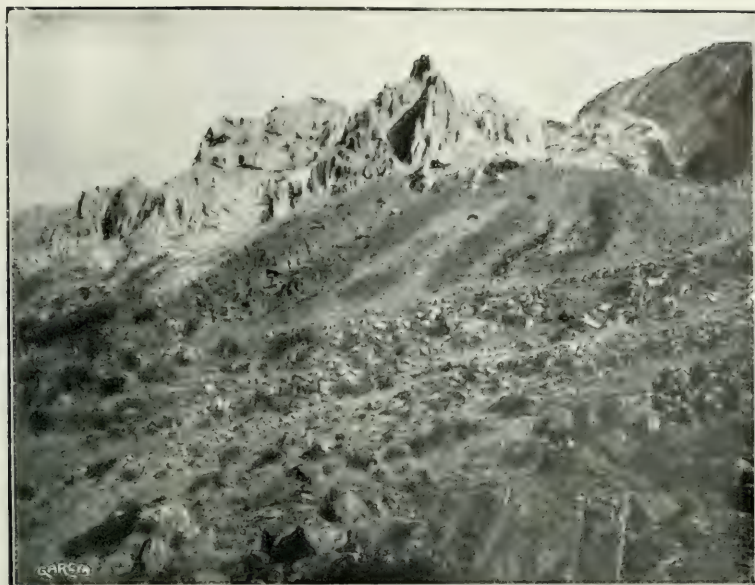
Aspecto da Ilha da Trindade, sendo digno de nota a franca desagregação do terreno.
