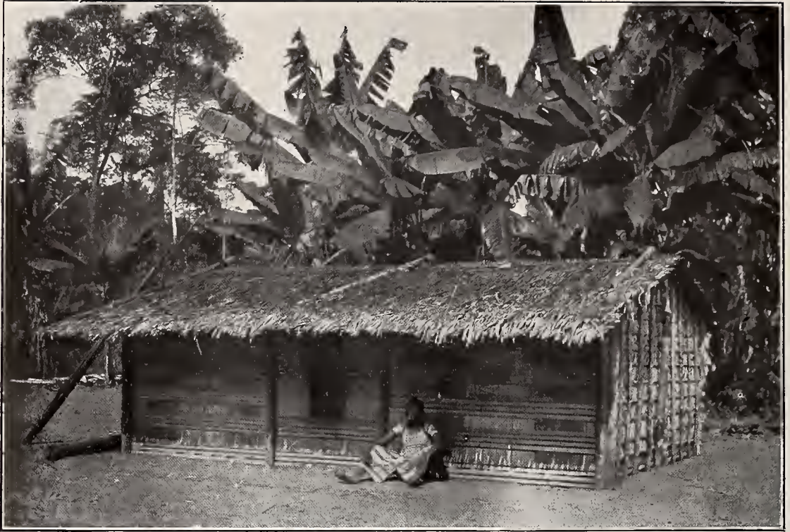
Abb. 34. Wohnhaus in Makonanám (Fam. Ojek), Span. Guinea.
