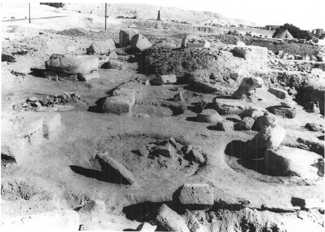
b) 1. Säulensaal (II/1972); Geländebeschaffenheit nach dem Wegräumen des Oberflächenschutts: Substruktion der Säulen, im Vordergrund Verlauf der nördlichen Außenmauer (Fundamentgraben) der Südkapellen
