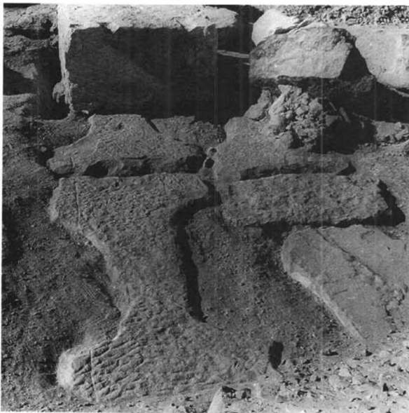
b) Frontmauer des 2. Säulensaals (II/1972), Fundamentmauerwerk mit horizontal aufgespaltenen Anubis-Sphingen in Wiederverwendung
