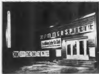
Fritz Staars neue Kammerstücke in der Kaiserhalle, Wilmersdorf
