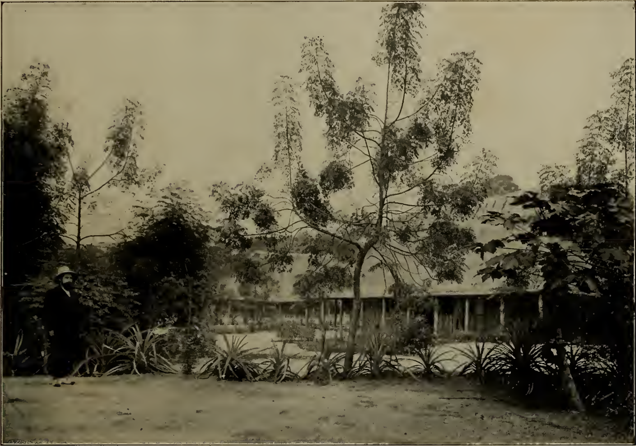
POSTE COMMERCIAL (DISTRICT DE L'ÉQUATEUR)
