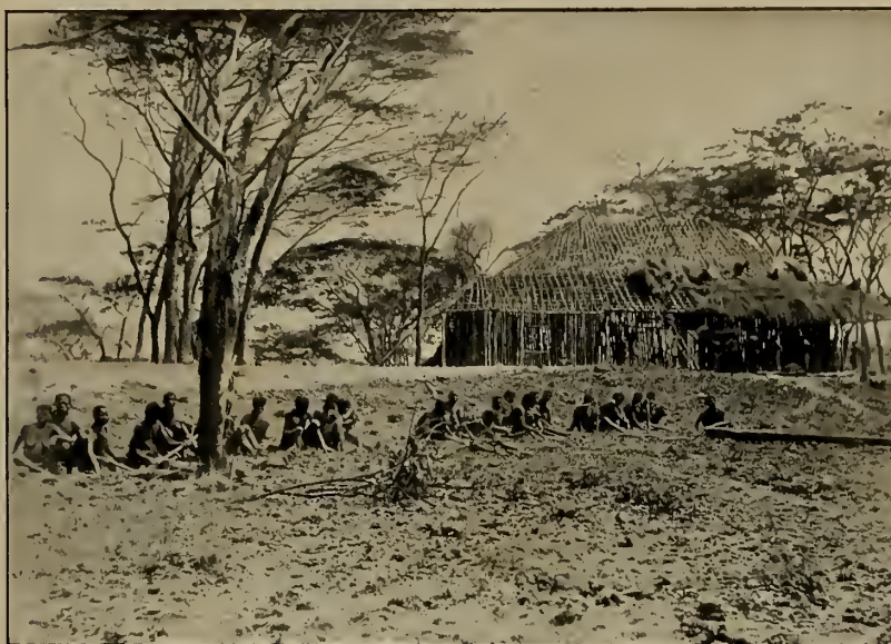
CONSTRUCTION D'UNE HABITATION (KATANGA)
