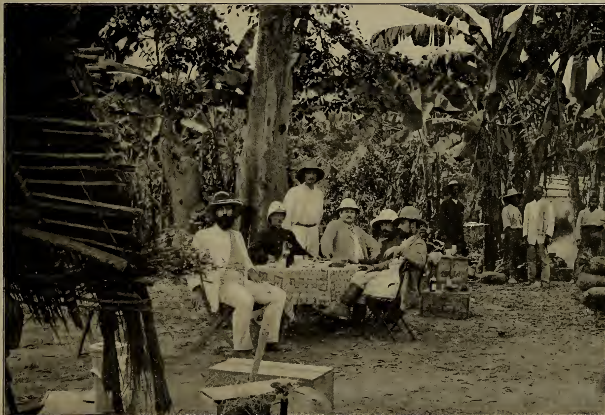
UN DÉJEUNER SOUS LES BANANIERS A L'ÉPOQUE DE LA CONSTRUCTION DU CHEMIN DE FER
