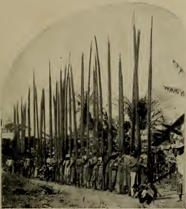
TRAVAILLEURS APPORTANT DES RACHIS DE PALMIER-RAPHIA DESTINÉS A LA CONSTRUCTION D'UNE TOITURE
