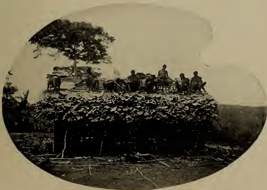
QUATRIÈME PHASE DE LA CONSTRUCTION D'UNE HABITATION
