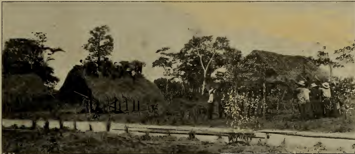
CONSTRUCTION DE HANGARS COUVERTS DE CHAUME
