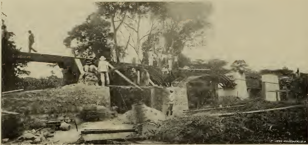
CONSTRUCTION DU PONT DE LA LUKI (MAYUMBE)
