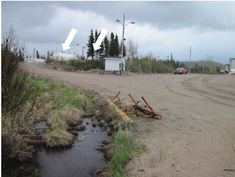
Photo 7 Réservoirs hors sol sur la propriété du camp Okaopéo au km 180.
