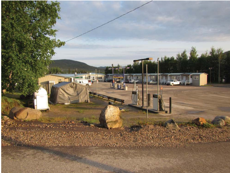
Photo 15 Réservoir de propane et pompes distributrices de diesel et d'essence sur la propriété des Motels de l'Énergie inc.
