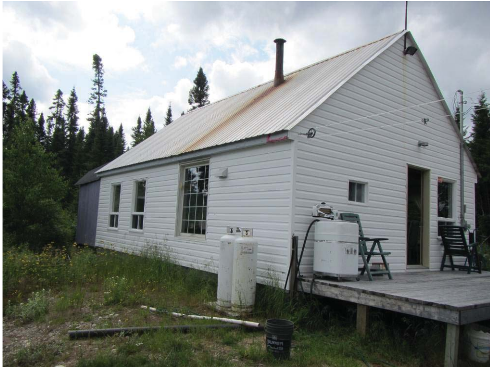
Photo 5 Chalet au km 178.
