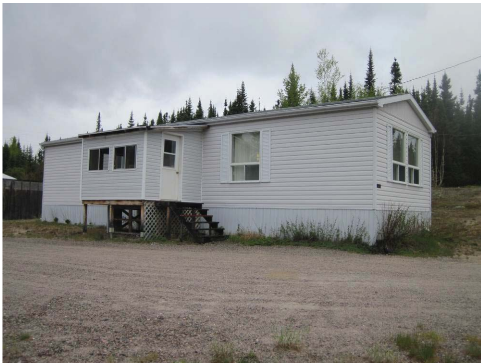
Photo 10 Chalet au km 199,5.
