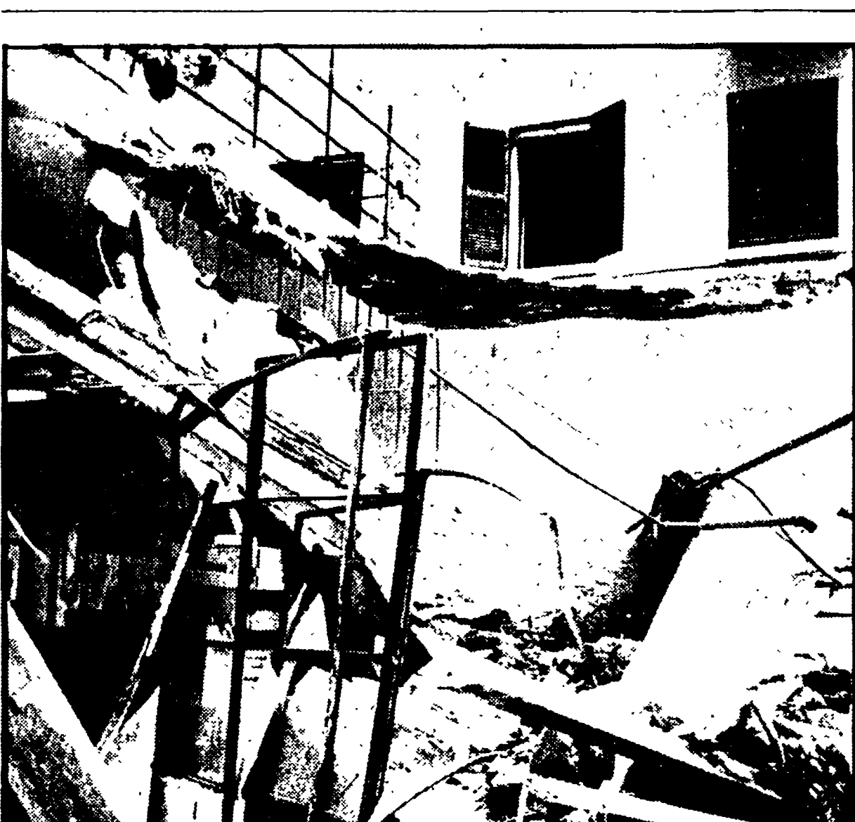
CROLLO A TRIONFALE Vasche da bagno, lavandini, scaldabagni, stufe ed altra merce per il valore di diversi milioni di lire, sono rimasti distrutti nel crollo del soffitto di un magazzino della ditta «Western spa» in via Caracciolo 19, al quartiere Trionfale. Erano da poco passate le 13,30, quando gli inquilini degli appartamenti che si trovano sopra al magazzino hanno sentito il soffitto del deposito cedere e sono precipitati nel soffitto si è prima incurvato e poi ha ceduto del tutto, distruggendo la merce che era stata scaricata solo due giorni fa. Nella foto: il magazzino devastato dal crollo.
