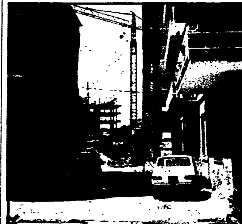
Palazzi in costruzione a Isernia: chi ci abiterà?
