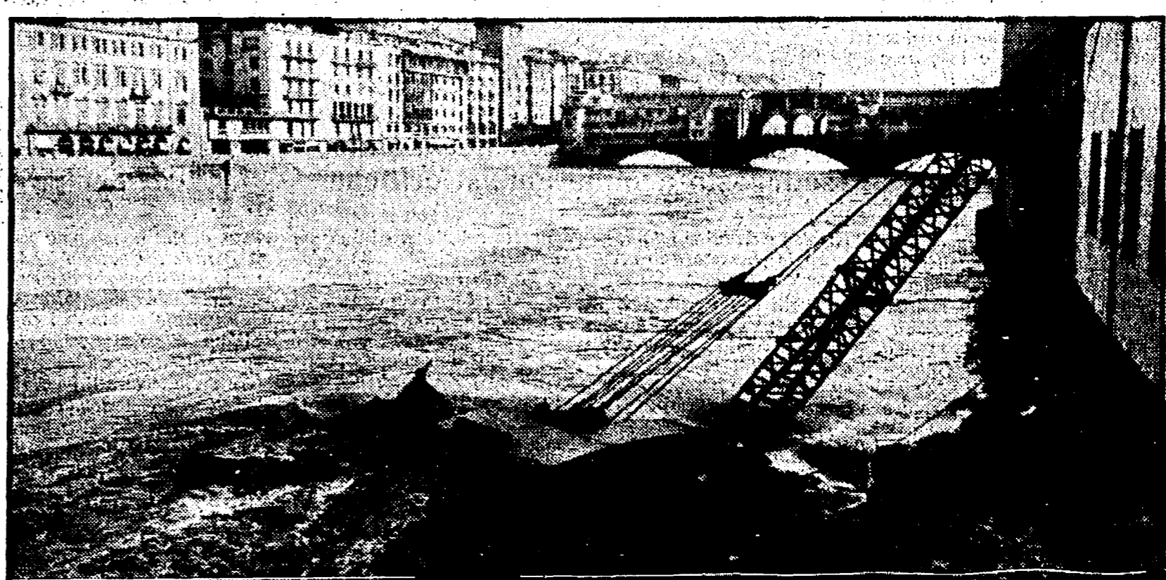
Una gru che serviva a dragare il fondo del fiume, travolta dalla piena dell'Arno.
