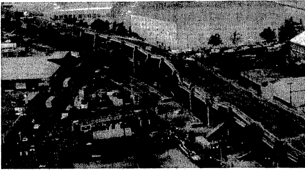
La sopraelevata di San Francisco crollata in 12 secondi
