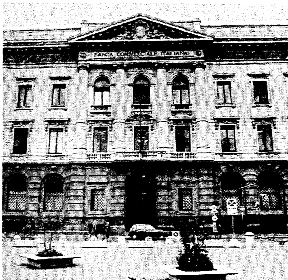
La sede centrale della Comit in piazza della Scala a Milano
