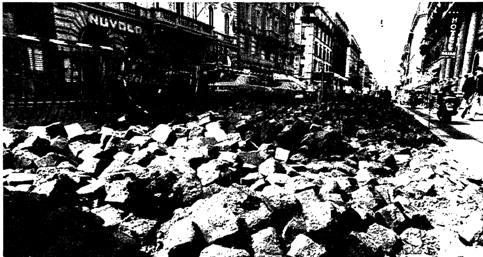
Lavori in corso a via Nazionale
