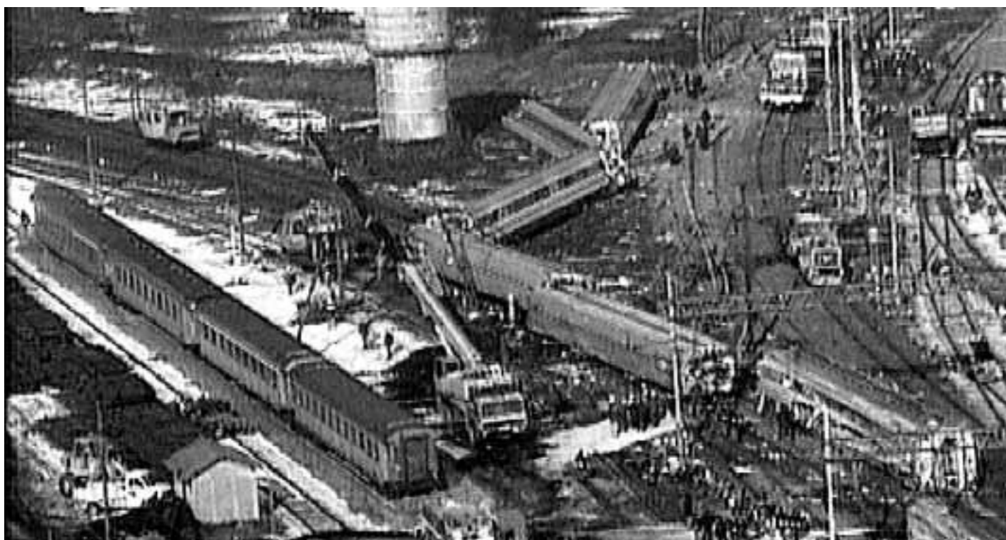
Una veduta aerea del deragliamento del Pendolino ripresa dalla televisione
