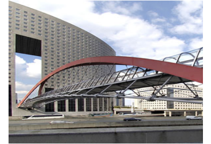
Japan Bridge La Défense , France 1994
