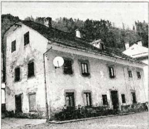
Dimnik Demšarjevih v Železnikih po potresu "kliče" po obnovi.
