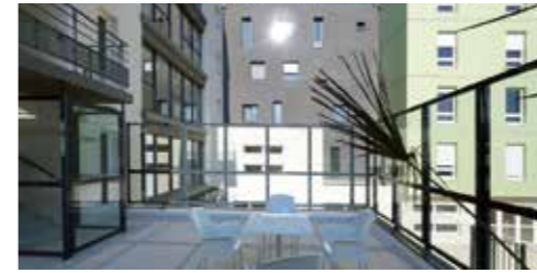
E.H.P.A.D. et RSS Le Clos des Peupliers CRÉATION D'UN E.H.P.A.D. DE 90 LITS, D'UNE R.S.S. DE 9 APPARTEMENTS ET D'UN ACCUEIL DE JOURS DE 10 PLACES BOBIGNY (93) MAÎTRE D'OUVRAGE : SODEARIF COÛT : 8 543 000€ H.T. - Achevé en Décembre 2012 SURFACE : 5 483 m 2 Shon - 877 m 2 Shon Parking en Sous sol.
