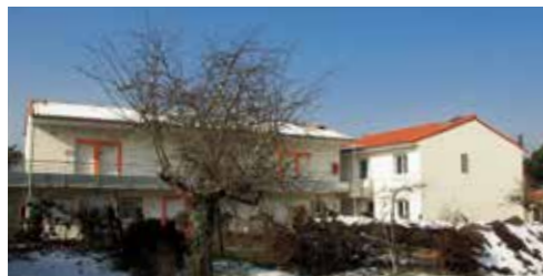
ITEP Millefleurs CRÉATION DE L'INTERNAT DE L'ITEP "MILLEFLEURS" VILLENAVE D'ORNON (33) MAÎTRE D'OUVRAGE : A.R.I. COÛT : 522 380€ H.T. - Achevé en 2012 SURFACE : 362 m 2 Shon
