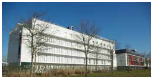
E.H.P.A.D. et Résidence Clos de l'Isle Macé CRÉATION D'UN E.H.P.A.D. DE 98 LITS ET D'UNE R.S.S. DE 32 APPARTEMENTS DÉMARCHE HAUTE QUALITÉ ENVIRONNEMENTALE REZE (44) MAÎTRE D'OUVRAGE : SCI REZE - Groupe ORPEA S.A. COÛT : 9 026 600€ H.T. - Achevé en Novembre 2012 SURFACE : EHPAD 5 289 m 2 - RSS 2 095 m 2 Shon
