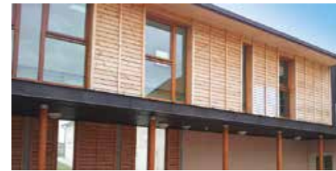
Résidence Sainte-Marthe EXTENSION & RÉNOVATION PARTIELLE D'UN E.H.P.A.D. DE 72 LITS ET D'UN ACCUEIL DE JOUR SAINT FRONT (16) MAÎTRE D'OUVRAGE : Centre d'Orientation Sociale COÛT : 1 350 000€ H.T. - Achevé en Avril 2013 SURFACE : 1 000 m 2 Shon
