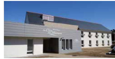
E.H.P.A.D. Le Clos des Mûriers CRÉATION D'UN E.H.P.A.D. DE 48 LITS BATZ SUR MER (44) MAÎTRE D'OUVRAGE : SARL NIORT 94 - Groupe ORPEA S.A. COÛT : 4 500 000€ H.T. - Achevé en 2012 SURFACE : 2 158 m 2 Shon
