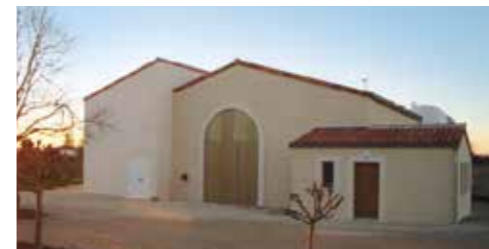
Distillerie Mercier CRÉATION D'UNE DISTILLERIE DE CAPACITÉ 4 ALAMBICS BREVILLE (16) MAÎTRE D'OUVRAGE : GAEC du Renouveau COÛT : 218 900€ H.T. - Achevé en 2013 SURFACE : 201 m 2 Shon
