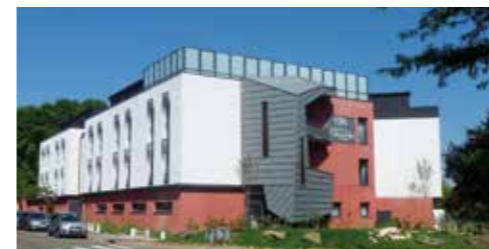
E.H.P.A.D. Le Clos des Lilas CRÉATION D'UN E.H.P.A.D. DE 84 LITS DONT 14 ALZHEIMER, 14 LITS GRANDS FRAGILISÉS ET UN PASA EAUBONNE (95) MAÎTRE D'OUVRAGE : SARL Niort 94 - Groupe ORPEA S.A. COÛT : 7 192 000€ H.T. - Achevé en Avril 2014 SURFACE : 4 360 m 2 Shon
