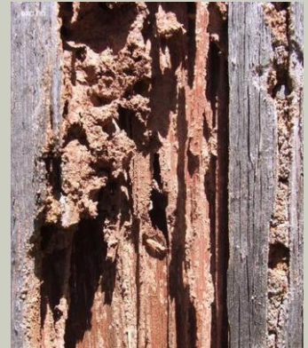
Galerías con barro
