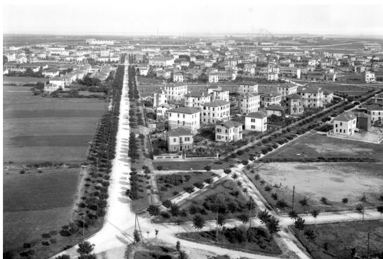
Fig. 16: Marghera, quartiere urbano (1928)
