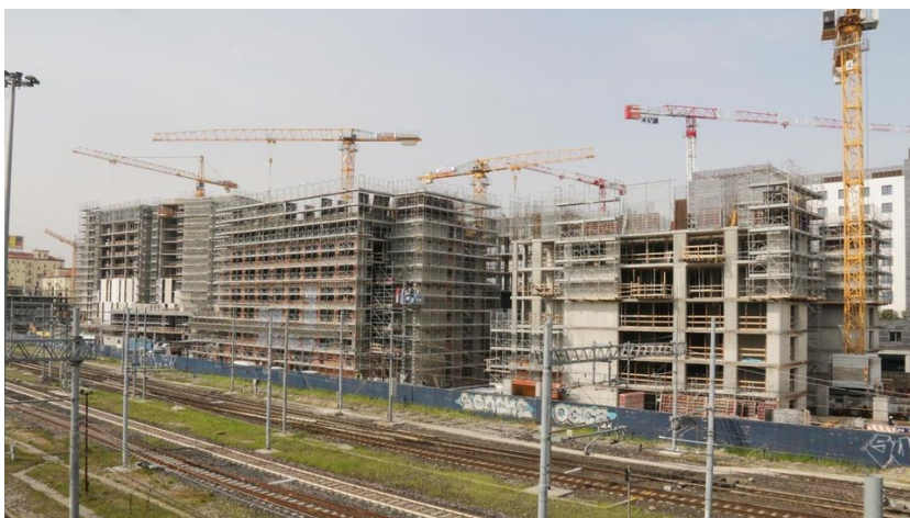
Fig. 31: Nuovi hotel in costruzione a Mestre (2019)
