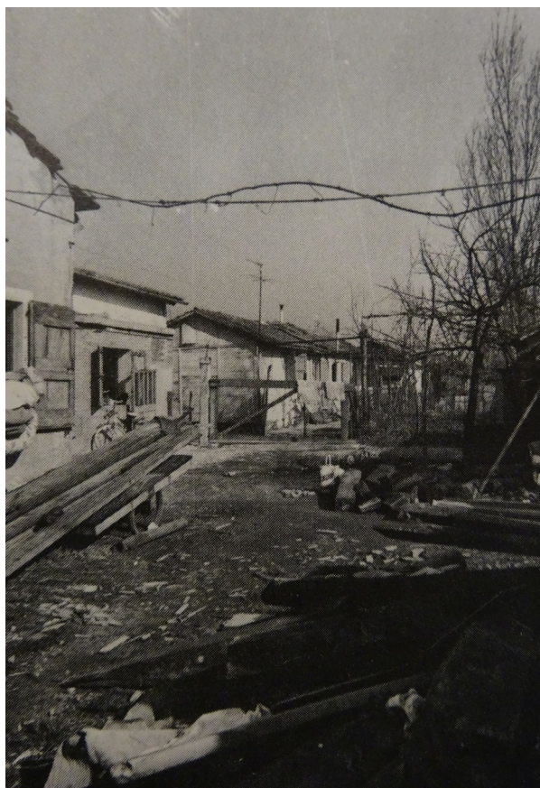
Fig. 17: Vedute del Villaggio Ca' Emiliani poco prima della sua demolizione (Anni '50)
