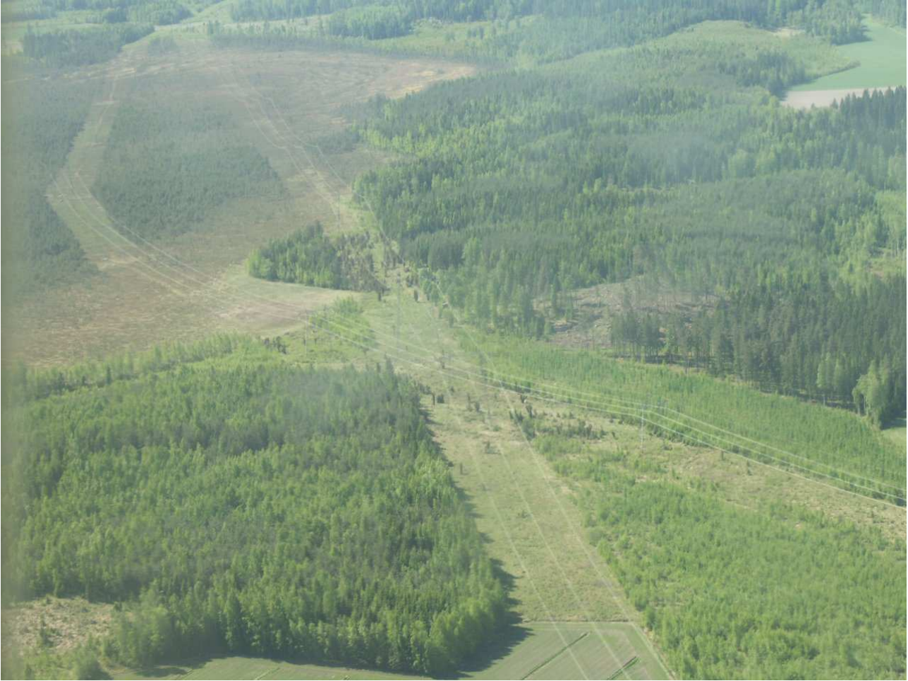
Nykyiset voimajohdot Ritassaarensuon länsiosassa katsottuna pohjoisesta etelään. Itse järvi jää kuvasta vasemmalle.
