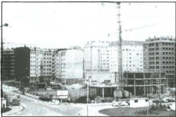
Bloques de viviendas en construcción
