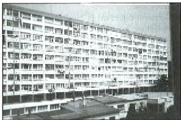
Bloque de viviendas sin suministro de calefacción centralizado
