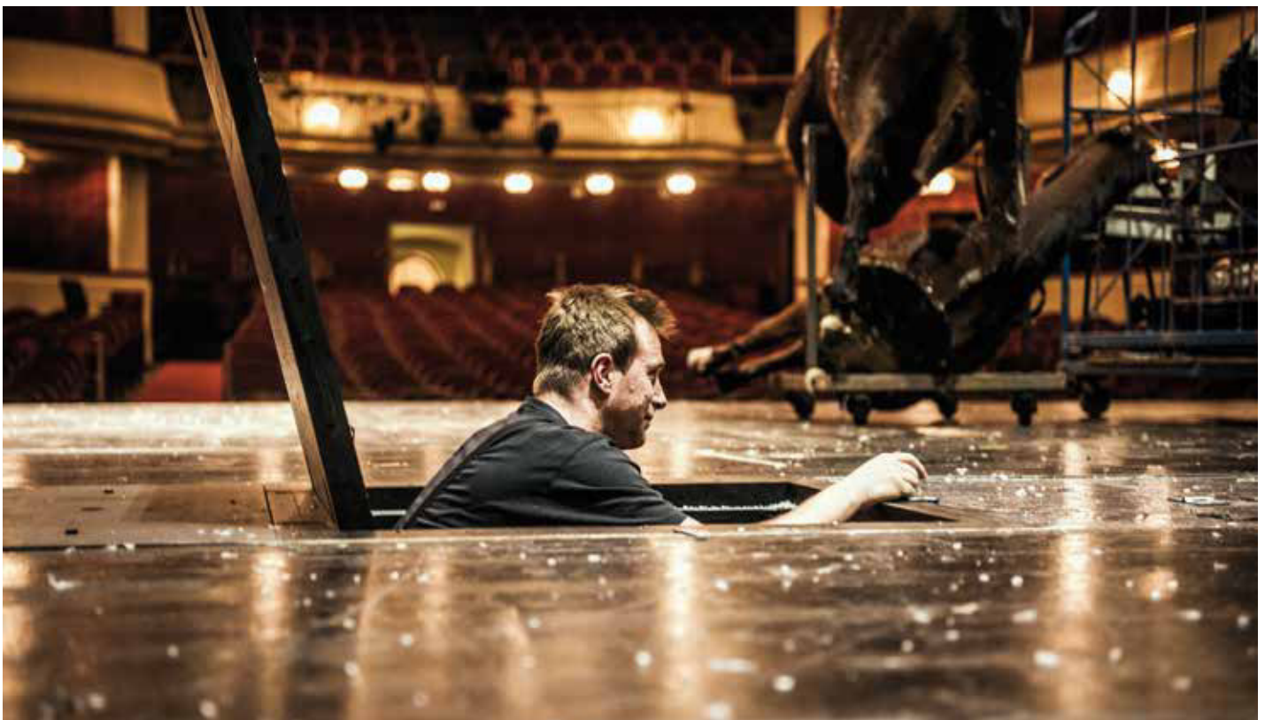
14:08 Arbeit an den Brettern, die die Welt bedeuten: Mit der Erneuerung der Bühnentechnik wird an der empfindlichsten Stelle des Theaters gearbeitet.
