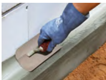
Ryc. 6.20. Zaokrąglenia płaszczyzny w narożnikach
