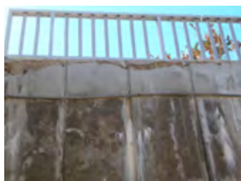
Uszkodzenia spowodowane reakcją kruszywa z betonu z alkaliami
