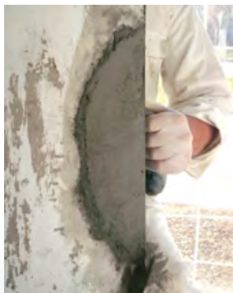
Ryc. 6.14. Reprofilacja uszkodzonych naroży
