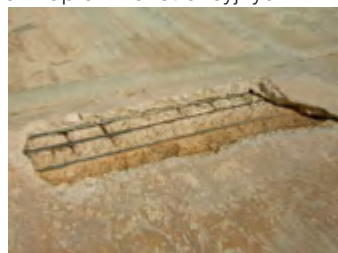
Uszkodzenia spowodowane erozją
