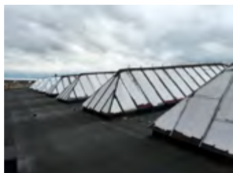
Ryc. 6.79. Natryskowa izolacja MasterSeal M 689 wykonana na szklanych świetlikach dachowych. Udostępnione przez: ELIN Andrzej Juszcak
