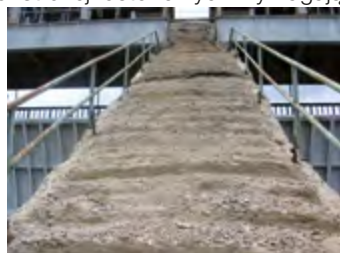
Uszkodzenia mrozowe
