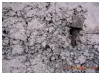
Uszkodzenia spowodowane działaniem soli
