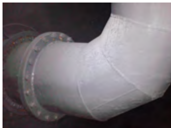
Ryc. 6.30. Powłoka polimocznikowa na nieregularnych elementach zbiornika wody. Udostępnione przez: DUKO ENGINEERING
