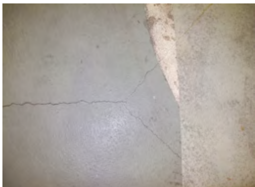
Ryc. 6.61. Rysy skurczowe na powierzchni parkingu
