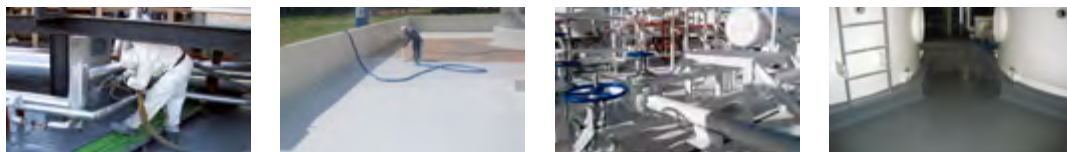
Ryc. 3.11. Przykłady zastosowania powłoki polimocznikowej w zakładach chemicznych
