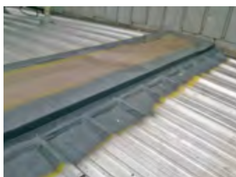
Ryc. 6.82. Powłoka polimocznika wyprowadzona na obróbki blacharskie podczas realizacji izolacji dachu w Gliwicach
