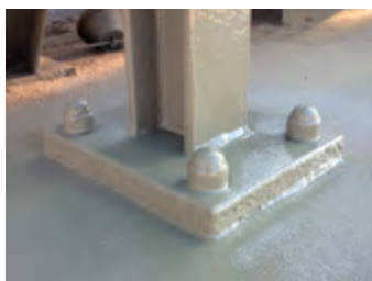
Ryc. 6.31. Szczelna izolacja wokół różnych detali i elementów
