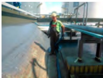
Ryc. 6.58. Powłoka MasterSeal M 689 aplikowana na różne i nawet bardzo nieregularne podkłady. Udostępnione przez: ERAL Usługi Techniczne
