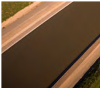
Ryc. 6.2. Izolacja kanałów irygacyjnych
