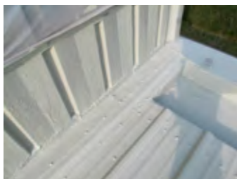
Ryc. 6.75. Natrysk polimocznika na blachę trapezową. Udostępnione przez: REMAK
