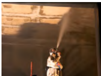
Ryc. 6.32. Powłoka polimocznikowa na wewnętrznych powierzchniach zbiornika wody. Udostępnione przez: DUKO ENGINEERING
