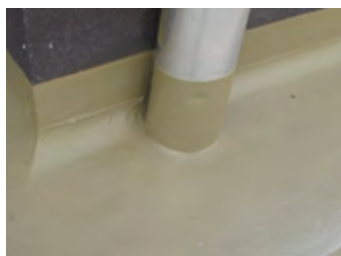
Ryc. 6.31. Szczelna izolacja wokół różnych detali i elementów
