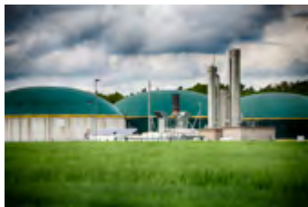
Ryc. 6.88. Wykorzystanie biogazu na potrzeby produkcji energii cieplnej z lokalnego systemu ciepłowniczego do ogrzania samych komór fermentacyjnych
