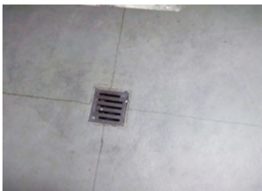
Ryc. 6.63. Wtórne zarysowania dylatacji skurczowych
