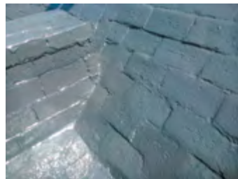
Ryc. 6.58. Powłoka MasterSeal M 689 aplikowana na różne i nawet bardzo nieregularne podkłady. Udostępnione przez: ERAL Usługi Techniczne
