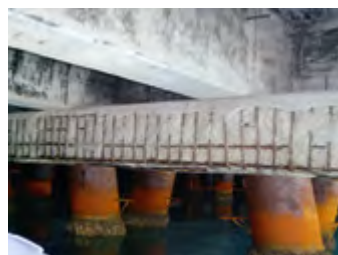
Uszkodzenia spowodowane działaniem soli
