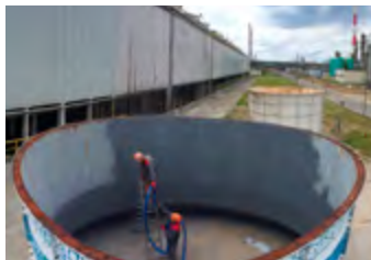
Ryc. 3.3. Wykonanie powłoki MasterSeal M 689 na powierzchni konstrukcji dyfuzorów. Udostępnione przez: ERAL Usługi Techniczne.
