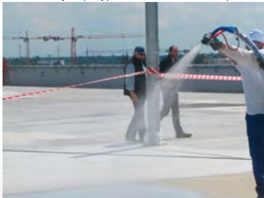
Prace wykończeniowe żywicą polimocznikową w technologii Overspray
