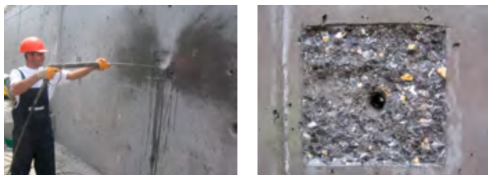
Ryc. 6.17. Zwilżanie powierzchni betonu
