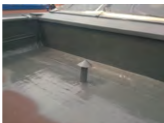
Ryc. 6.86. Kominki wentylacyjne w szczelnej izolacji MasterSeal M 689 . Udostępnione przez: REMAK
