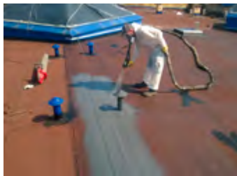
Ryc. 6.85. Powłoka polimocznika wyprowadzona na kominki. Udostępnione przez: REMAK
