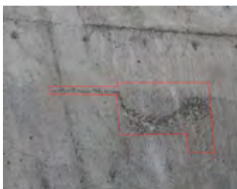
Ryc. 6.4. Fragmenty przygotowane do wykucia betonu
