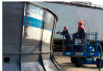
Ryc. 3.3. Wykonanie powłoki MasterSeal M 689 na powierzchni konstrukcji dyfuzorów. Udostępnione przez: ERAL Usługi Techniczne.
