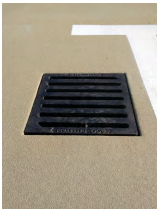
Ryc. 6.73. Powierzchnia parkingu wykonana technologią Overspray
