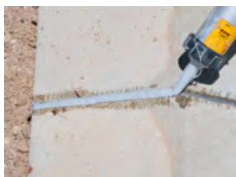
Ryc. 6.68. Aplikacja materiału MasterSeal NP 474
