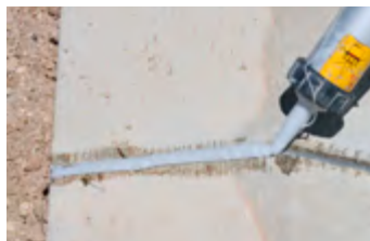
Ryc. 6.8. Etapy wypełniania dylatacji
