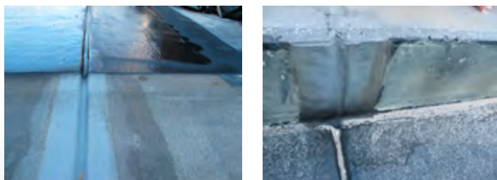
Ryc. 6.84. Dylatacja konstrukcyjna zabezpieczona taśmą MasterSeal 930 i powłoką polimocznikową w Afrykarium Oceanarium we Wrocławiu
