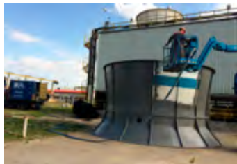
Ryc. 3.3. Wykonanie powłoki MasterSeal M 689 na powierzchni konstrukcji dyfuzorów. Udostępnione przez: ERAL Usługi Techniczne.
