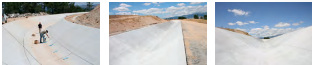
Ryc. 6.7. Wypełnienie dylatacji
