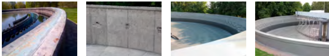
Ryc. 6.53. Zbiorniki w oczyszczalni ścieków przed remontem, w trakcie i po wykonaniu izolacji z polimocznika MasterSeal M 689
