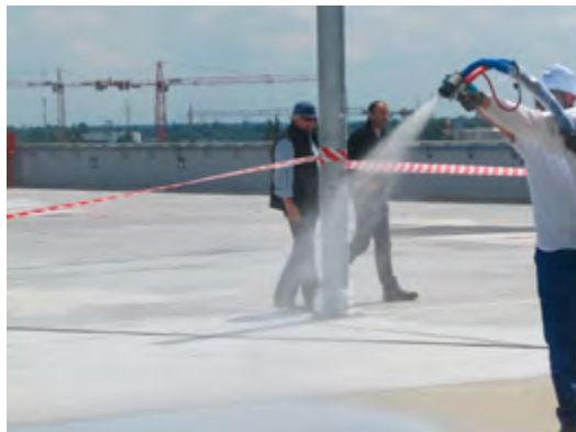
Ryc. 6.72. Prace wykończeniowe żywicą polimocznikową w technologii Overspray
