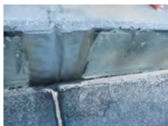
Ryc. 6.69. Dylatacja konstrukcyjna zabezpieczona polimocznikiem aplikowanym na taśmie hepalonowej
