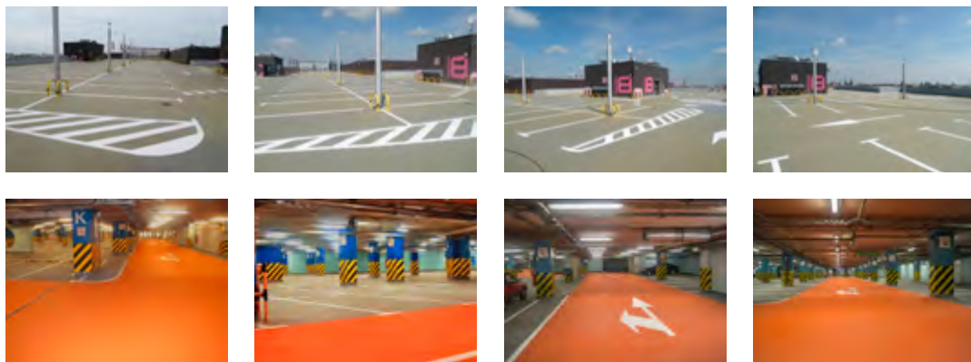
Ryc. 6.70. Aplikacja polimocznika z kolorystyką użytkową
