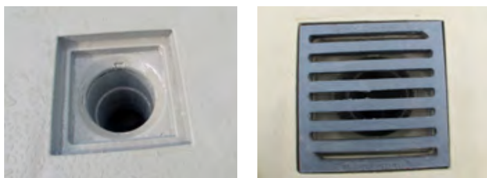
Ryc. 6.67. Wykończenie hydroizolacji za pomocą powłoki polimocznikowej przy odwodnieniach
