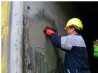
Ryc. 6.18. Nakładanie szpachli kosmetycznej
