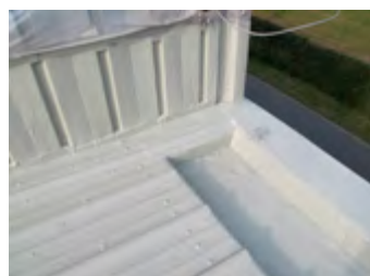
Ryc. 6.82. Powłoka polimocznika wyprowadzona na obróbki blacharskie podczas realizacji izolacji dachu w Gliwicach
