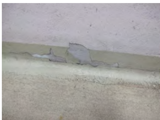
Ryc. 6.64. Pęknięcia cokołów przyściennych
