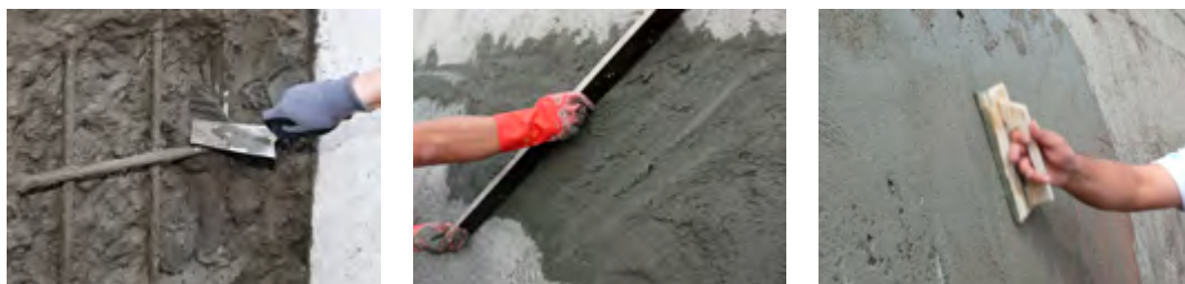
Ryc. 6.13. Aplikacja materiałów naprawczych
