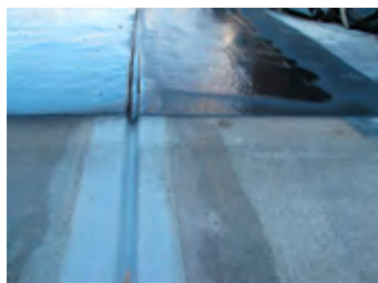
Ryc. 6.9. Układanie taśmy hepalonowej
