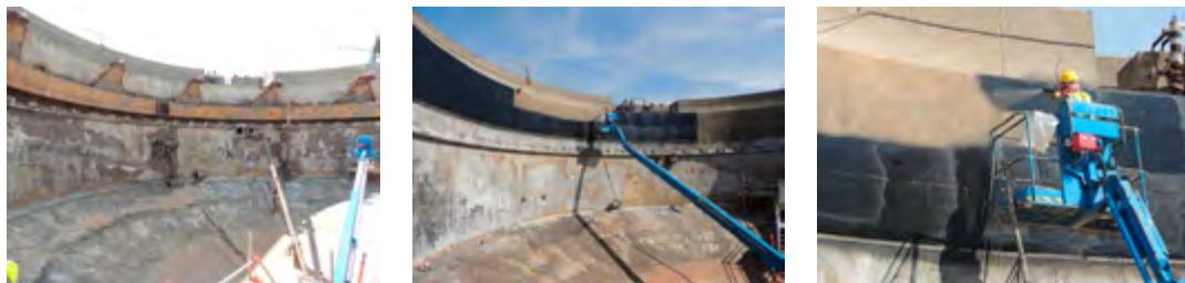
Ryc. 6.54. Aplikacje powłoki polimocznikowej w oczyszczalni
