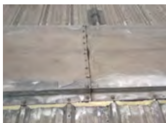
Ryc. 6.82. Powłoka polimocznika wyprowadzona na obróbki blacharskie podczas realizacji izolacji dachu w Gliwicach
