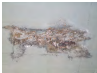
Uszkodzenia spowodowane reakcją kruszywa z betonu z alkaliami
