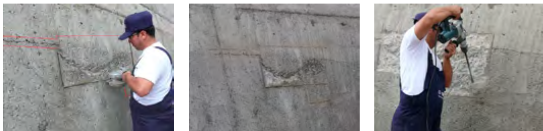
Ryc. 6.5. Wykuwanie lekkim młotem pneumatycznym
