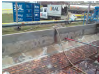
Ryc. 6.58. Powłoka MasterSeal M 689 aplikowana na różne i nawet bardzo nieregularne podkłady. Udostępnione przez: ERAL Usługi Techniczne
