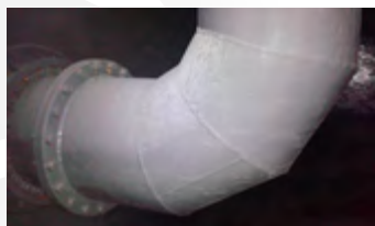
Ryc. 6.36. Powłoka polimocznikowa na instalacyjnej rurze stalowej. Udostępnione przez: DUKO ENGINEERING
