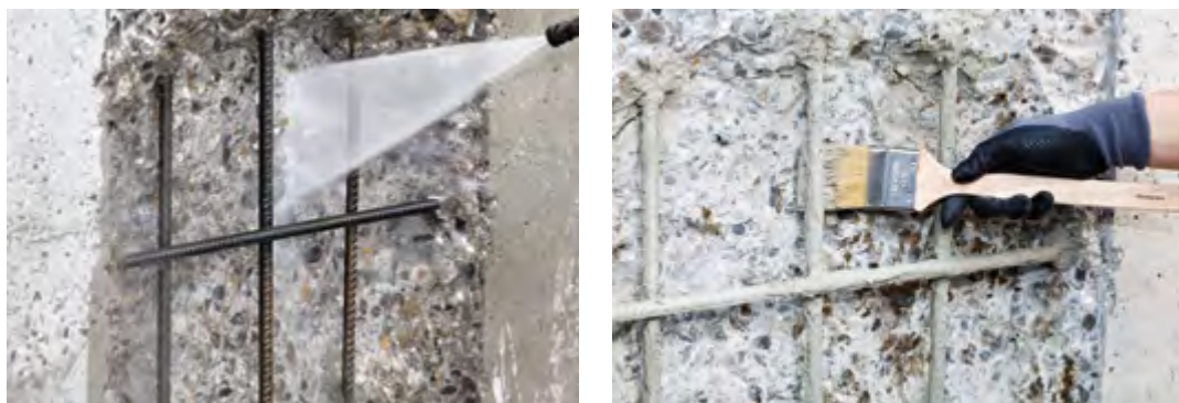
Ryc. 6.11. Oczyszczanie zbrojenia z rdzy i zabezpieczanie go inhibitorem korozji
