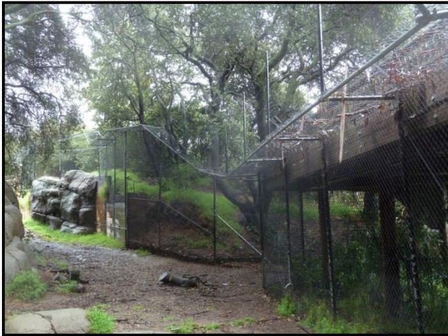
Barrera de contención de malla con un ángulo superior de 90 grados M. Jeffries
