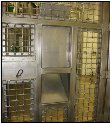
Conducto dispensador de alimento. Vista interior. M Wagoner
