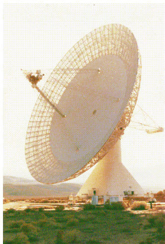
Fig. 1.-El radiotelescopio de Owens Valley, en California. El paraboloide de 40 m de diámetro, con montura altoacimutal, trabaja con ondas comprendidas entre un centímetro y un metro.
