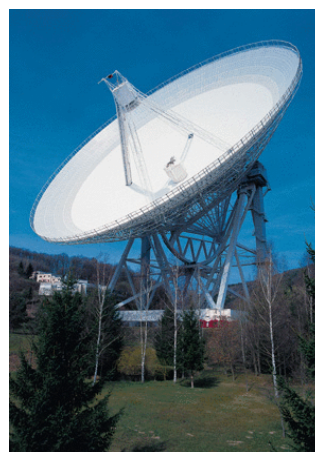
Fig. 4. El radiotelescopio de Effelsberg (Alemania). También la montura de este instrumento es altoacimutal. El casquete más interno (de 60 m de diámetro), que en ningún punto difiere en más de 0,6 mm del paraboloide ideal, se utiliza para las ondas milimétricas. La superficie completa se utiliza para ondas comprendidas entre 6 y 92 cm.
