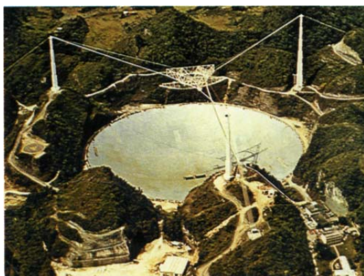
Fig. 3. El gran radiotelescopio de Arecibo (Puerto Rico). El colector, de 305 m de diámetro, está constituido por 27.000 paneles de aluminio densamente perforados para permitir el drenaje del agua de lluvia. El instrumento está orientado hacia el cenit, pero el receptor que, sostenido por tres pilares se encuentra en el foco del colector, se puede desplazar lateralmente para poder observar hasta una distancia de 20° del cenit. Por sus grandes dimensiones, este instrumento es adecuado para ser utilizado como transmisor en estudios con radar.
