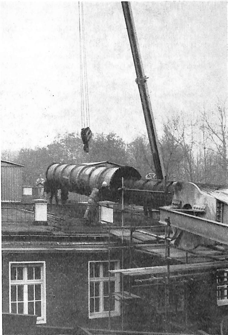
Ein 70-t-Autodrehkran mußte her, um die fertige Tubushälfte am Fernrohr zu montieren. Vom Südhof aus wurde der Rohrkörper auf das Sternwartendach gebracht, vom Nordhof aus dann über den inneren Tubus „gefädelt“ und schließlich an den Deklinationsquerträger angeschraubt. Sobald die Witterung wieder ständige Arbeit im Freien zuläßt, werden die Arbeiten fortgeführt. Und wenn nichts Unvorhergesehenes eintritt, kann im Spätherbst des Jahres wieder mit dem Großen Refraktor beobachtet werden.
