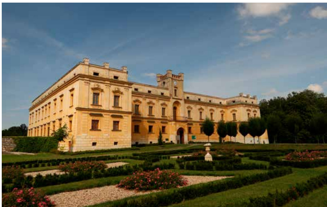
Obrázek 3.34: Obnovený zámecký park ve Slezských Rudolticích, 2020
