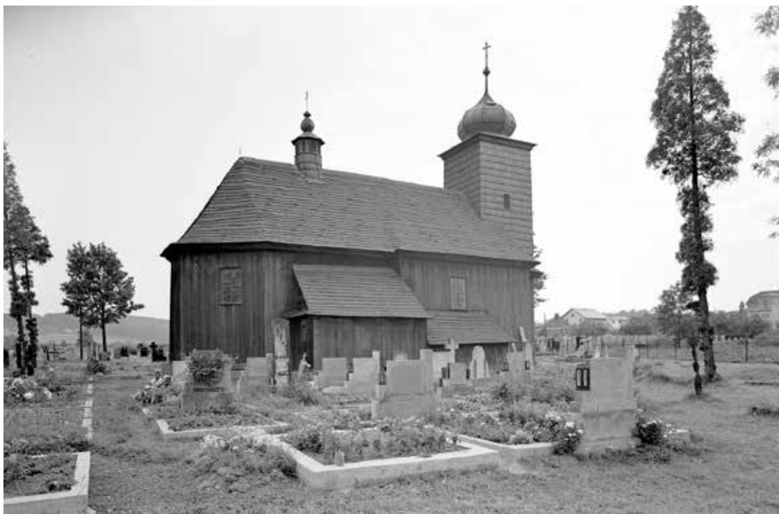
Obrázek 6.26: Kostel sv. Petra a Pavla v Albrechticích z roku 1766, přejímající již prvky barokní zděné architektury
