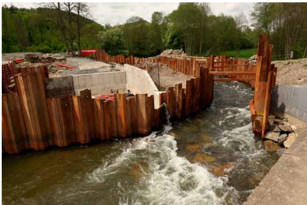
Obrázek 3.20: Stavební práce v areálu připravovaného vodního díla Nové Heřminovy, 2021
