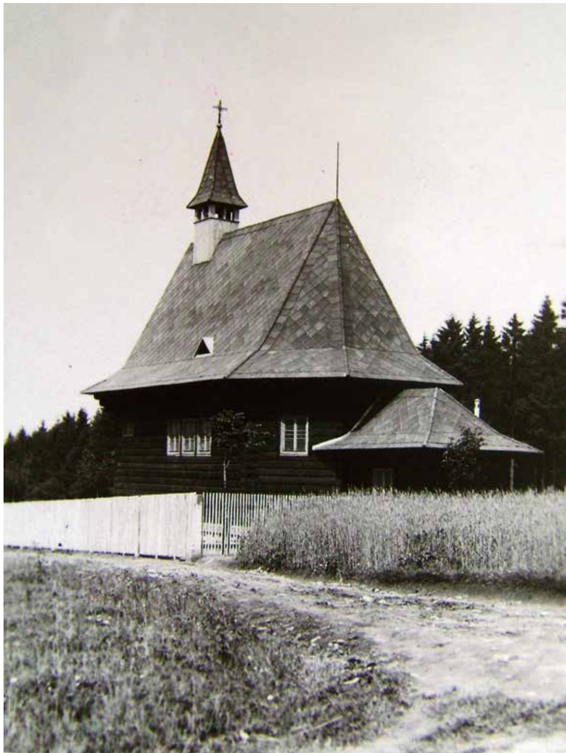
Obrázek 6.29: Kostel sv. Cyrila a Metoděje v Hrčavě z roku 1936 podle projektu architekta Karla Nahůnka, kombinující tradiční exteriér s modernistickým interiérem
