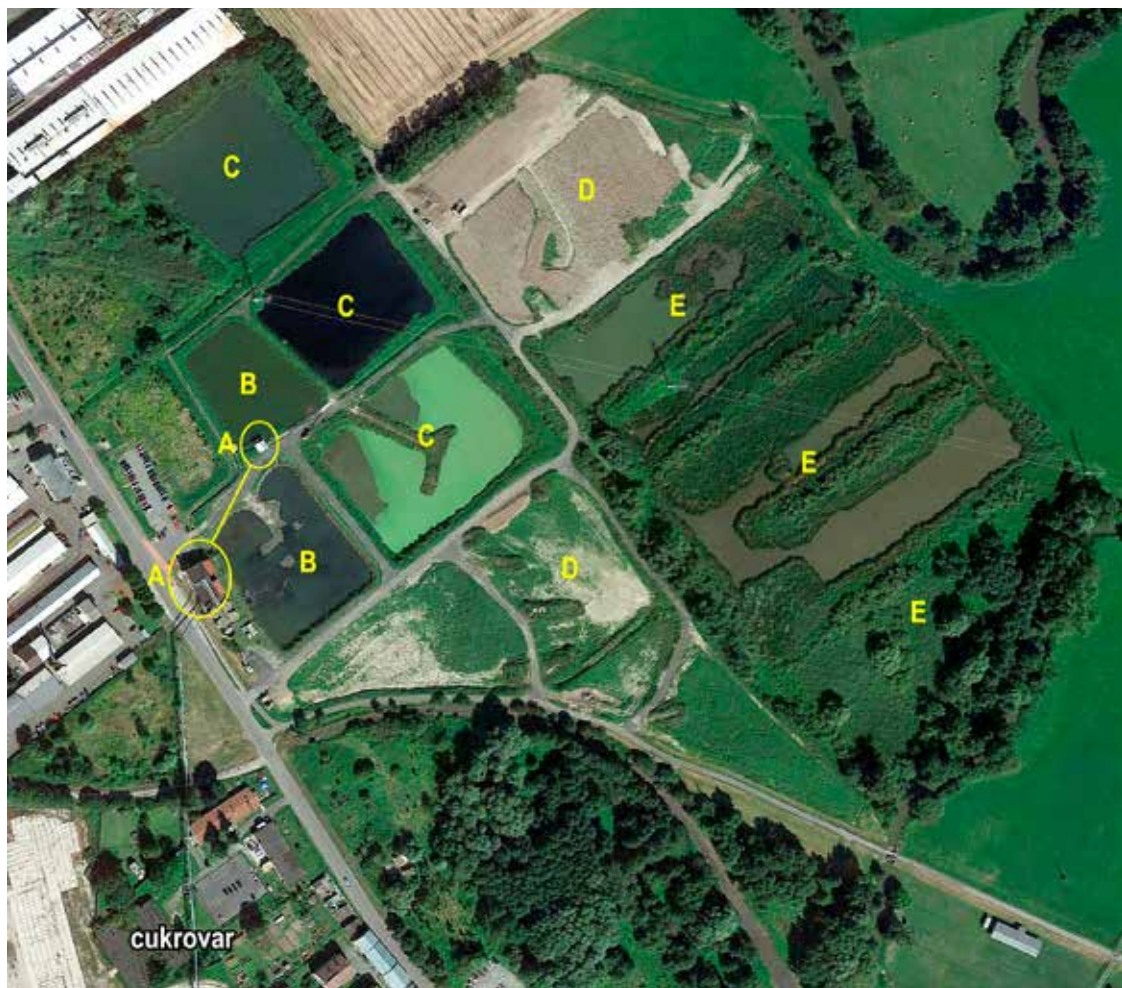
Obrázek 8.10: 2 Satelitní mapa areálu odkalovacích nádrží cukrovaru Opava-Vávrovice. A – čerpací stanice odpadních vod, B – akumulční nádrže, C – aktivní sedimentační nádrže, D – sedimentační nádrže s vysušenými odpadními kaly (určené k vybagrování), E – staré neužívané sedimentační nádrže v různém stádiu vegetační sukcese. Dle Roháček (2020, pozměněno)
