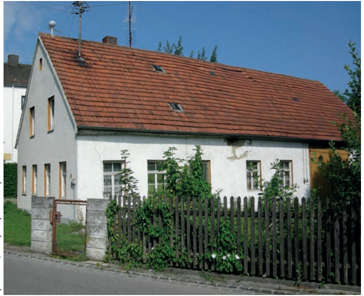
Die einstige Mozartsölde in Leitershofen: Hier lebte vor rund 500 Jahren Hans Motzhart, der erste historisch belegbare Vorfahre des späteren Musikgenies. Das Häuschen wurde 1897 neu gebaut und im vergangenen Jahr abgerissen.
