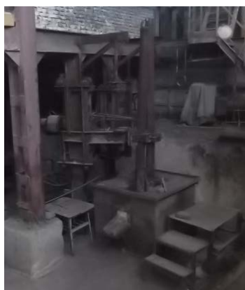
Рисунок 3. Опытная двухэлектродная однофазная рудотермическая печь с прямоугольной ванной
