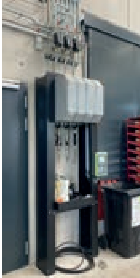
Abgabestation in der Werkstatt mit Schlauchaufroller an der Portalsäule und Managementsystem.
