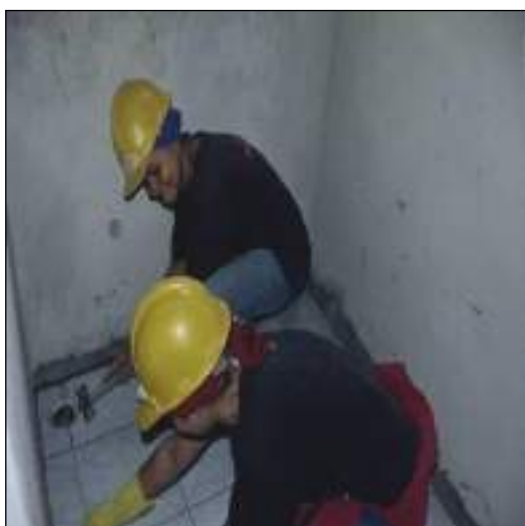
FIGURA 10: Equipe de assentamento de revestimentos cerâmicos.
