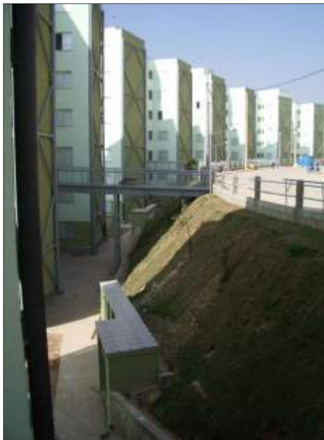
FIGURA 13: Vista do conjunto habitacional Brasilândia B23.
