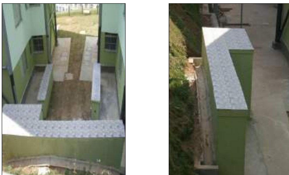
FIGURA 16: Abrigos de gás.
