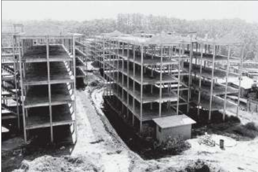
FIGURA 2: Vista dos “paliteiros” ou “pré-moldados” propostos pelo Programa Paulista de Mutirões.
