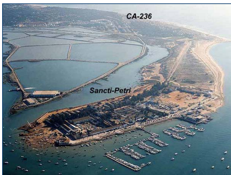
Península de Sancti Petri (Cádiz). Queda demostrada la inundabilidad de los terrenos. Sentencia AN 18-05-05
