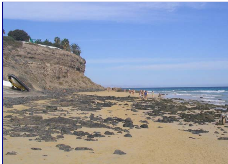
Fotografía tomada al pie del acantilado en Pájara (Fuerteventura)
