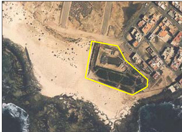
Depuradora construida tras la Ley de 1988 (T.M. La Oliva), incluido en el DL-113-LP
