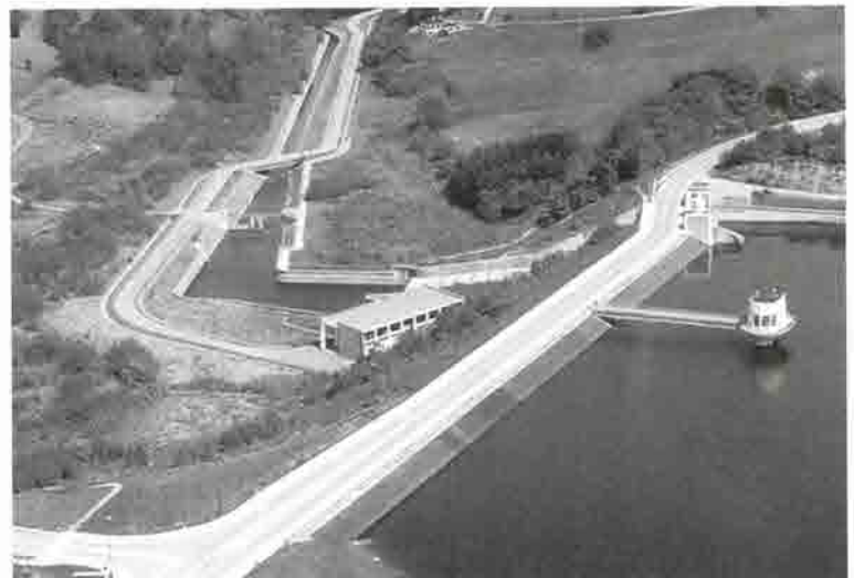
CERFONTAINE/Silenrieux. Barrages de l'Eau d'Heure. Prébarrage de Feronval. Cliché M.E.T.
