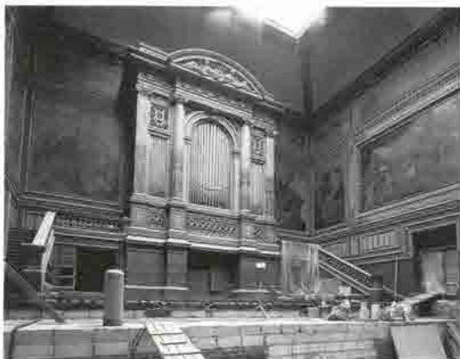
LIEGE/Liège. Conservatoire (chantier de restauration). Cliché G. Focant, DPat, © MRW.
