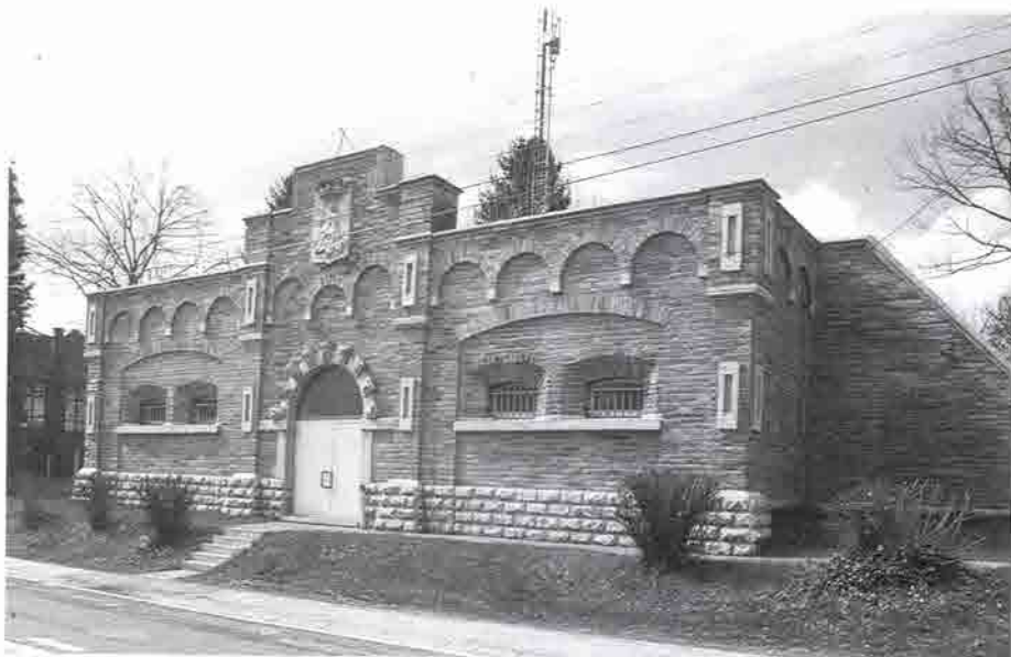
NEUFCHATEAU/Neufchâteau. Château d'eau. Cliché G. Focant, DPat, © MRW.
