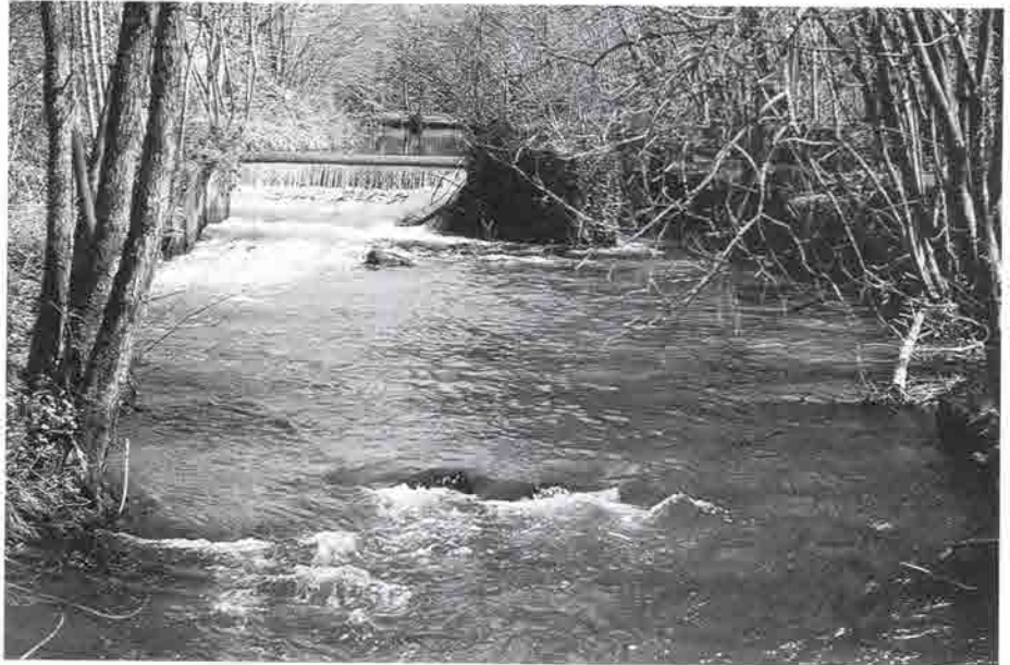
YVOIR/Spontin (Chansin). Vallée du Bocq. Cliché G. Focant. DPat. © MRW.
