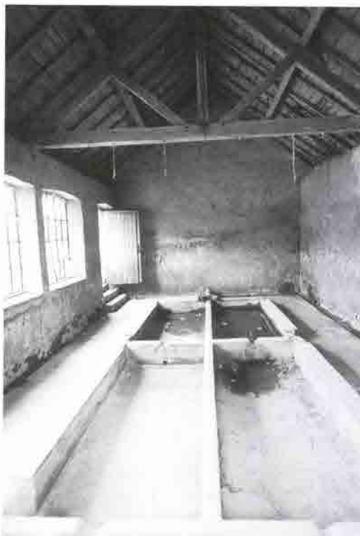
ATTERT/Nobressart. Lavoir. Cliché G. Focant, DPat. © MRW.
