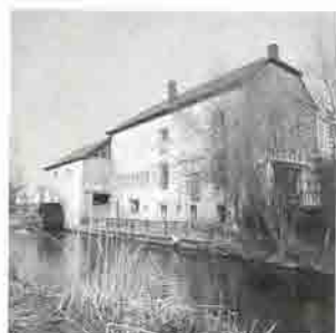
VIRTON – Le Moulin Naisse. Cliché Guy Focant, DPat, © MRW.
