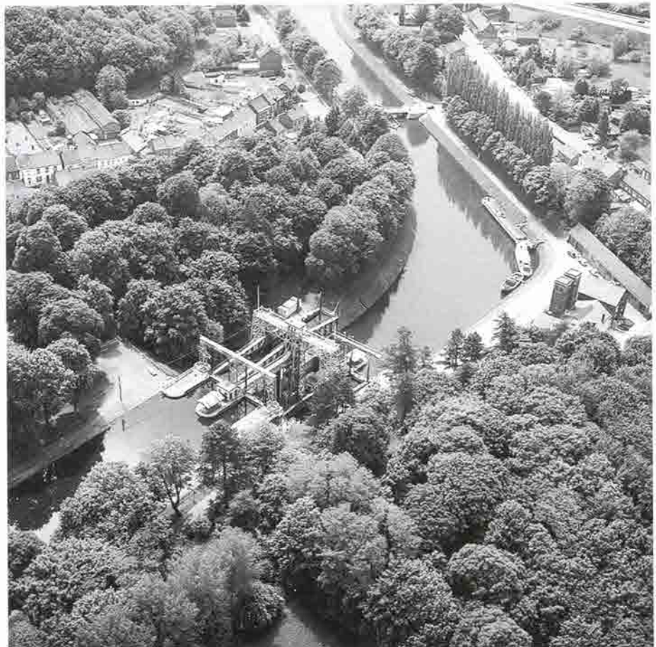
LA LOUVIERE/Strépy-Bracquenies. Ascenseur à bateaux. Cliché G. Focant, DPat, © MRW.
