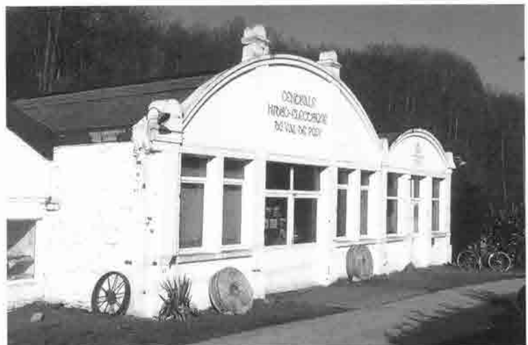
SAINT-HUBERT/Poix-Saint-Hubert. Centrale hydroélectrique du Val de Poix. Bâtiment. Cliché G. Focant, DPat, © MRW.
