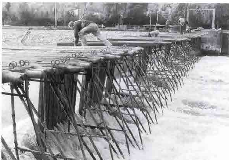
HASTIERE/Hastière. Ancien barrage à aiguilles. Cliché M.E.T., D434 (c).
