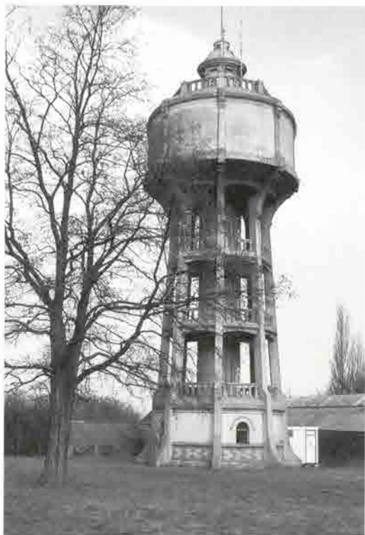
LIEGE/Liège. Château d'eau de Saint-Gilles. Cliché © CILE.
