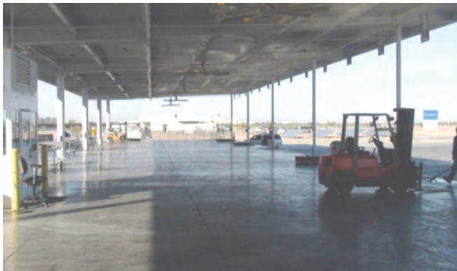
Inspección comercial Secundaria en el puerto fronterizo de San Luis II
