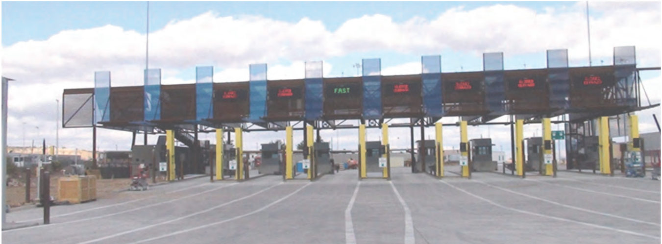
Instalaciones de Inspección Comercial Primaria, Puerto Fronterizo Mariposa: ocho carriles
