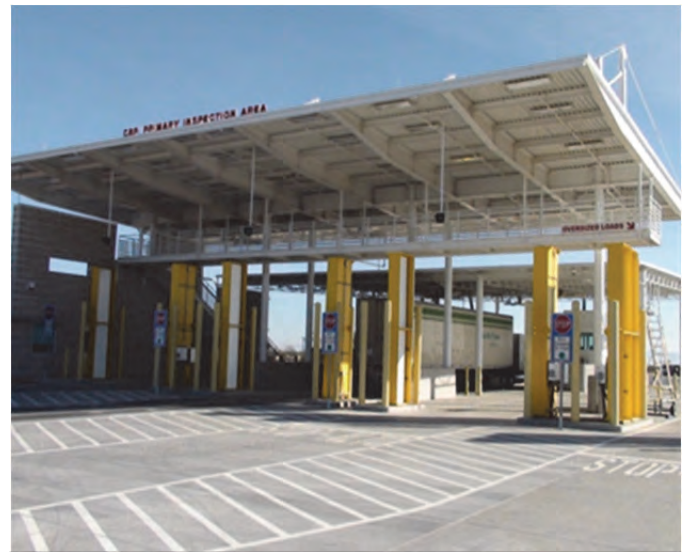
Instalaciones de Inspección Comercial Primaria en San Luis II
