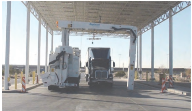
Inspección Non-Intrusiva en el puerto fronterizo San Luis II
