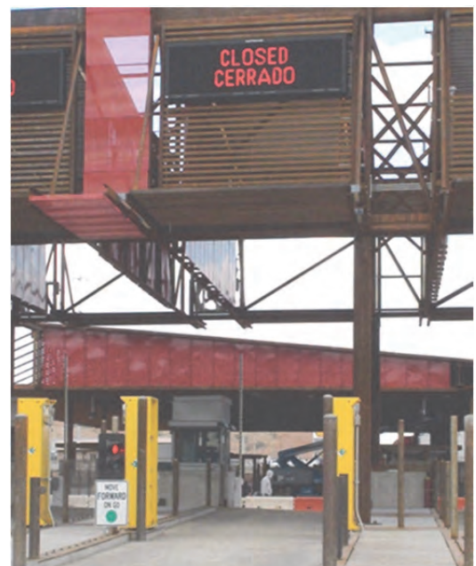
Carril de inspección POV: Puerto Fronterizo Mariposa en Nogales
