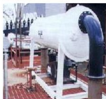
Vakuumski otplinjivač
