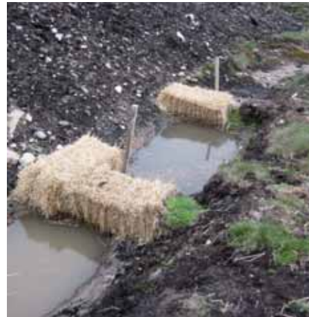
Halmbalar förhindrar slamtransport och grumling vid markarbeten i Skottland
