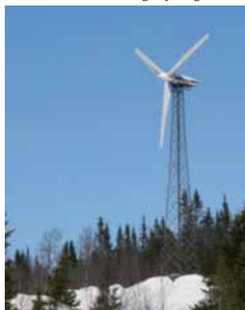
55 kW verk, navhöjd 23 m och rotordiam 8 m som tidigare stått vid Medstugan och nu ska uppföras som "gårdsverk" i Kläppe
