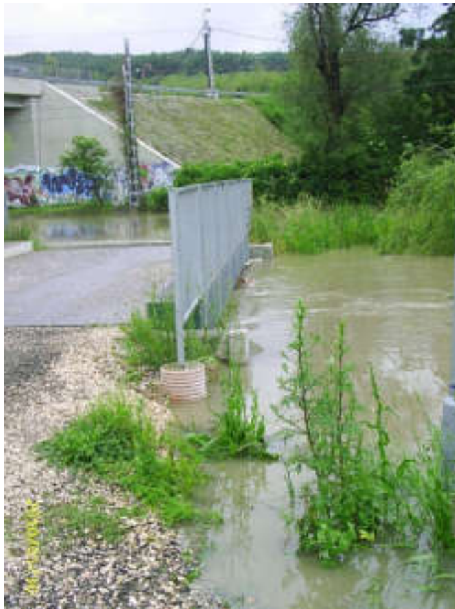
Híd a Hosszúréti-patak felett, háttérben a Balatoni úti felüljáró (Kána-tó felől) (forrás: FCSM ZRt.)
