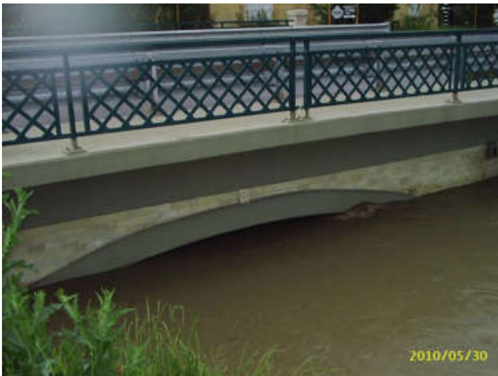
A Péterhegyi úti közúti híd felvízi oldala (forrás: FCSM ZRt.)
