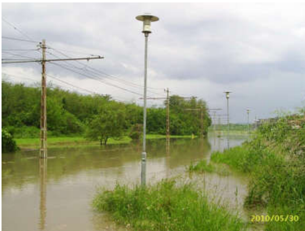
Kána-tó alsó része mellett elöntött villamospálya a patak hídjáról (forrás: FCSM ZRt.)
