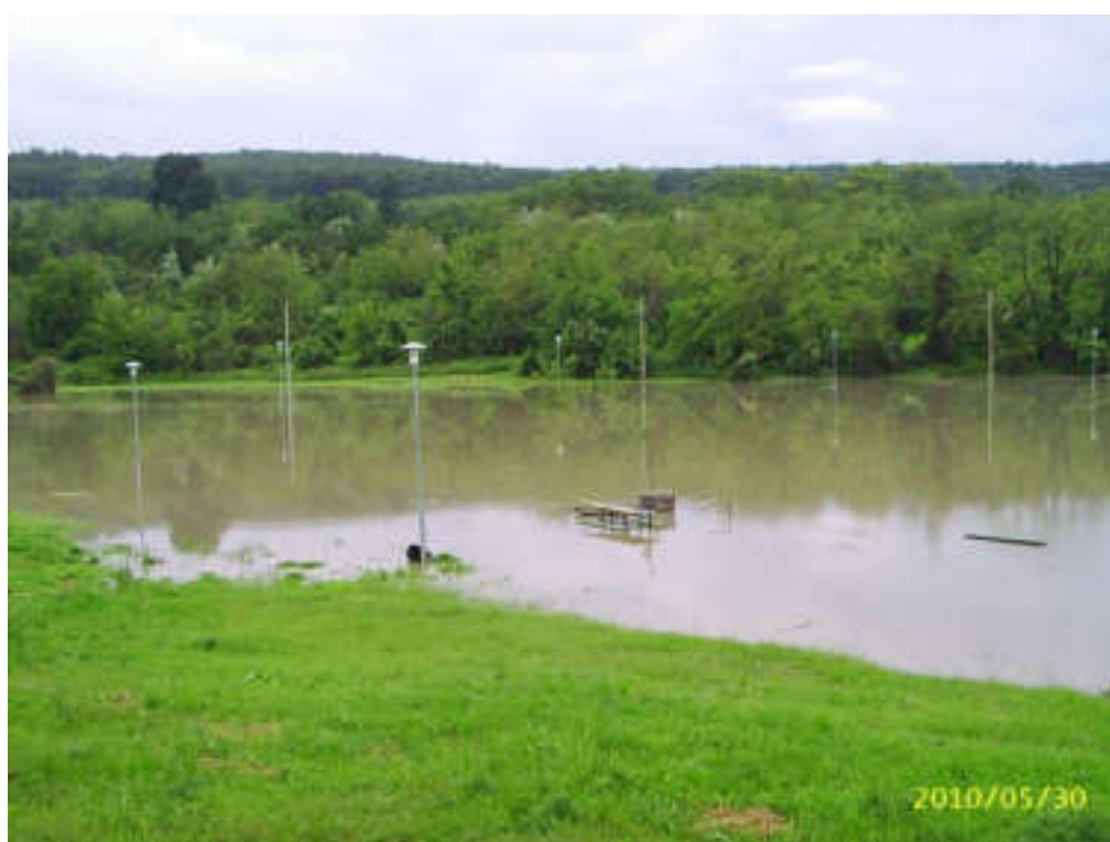
Kána-tó, legalsó tó, elzáró műtárgy (víz alatt) (forrás: FCSM ZRt.)
