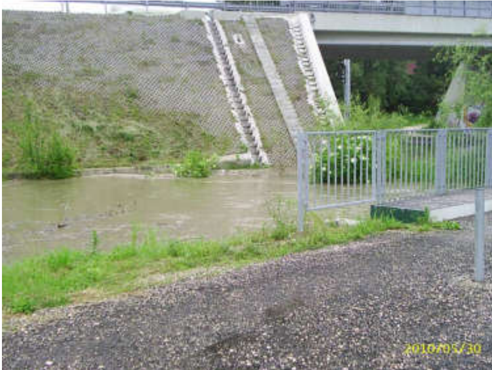
Balatoni úti felüljáró a patak hídjáról, a töltés alatt lévő átereszt a víz alatt van (forrás: FCSM ZRt.)
