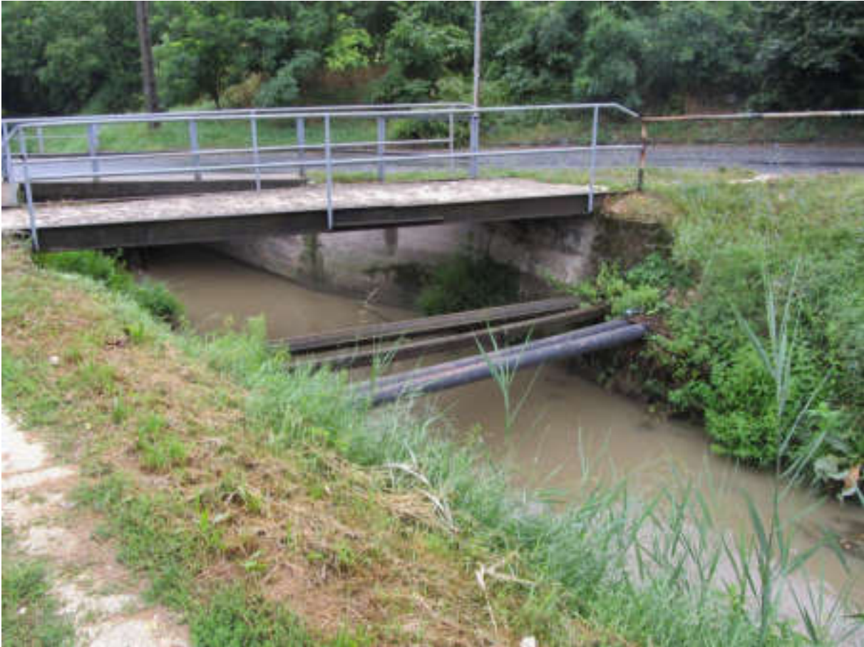
50. ábra: Az Ady Endre út alatti áteresztel előtt a gyaloghíd és a keresztező közművek
