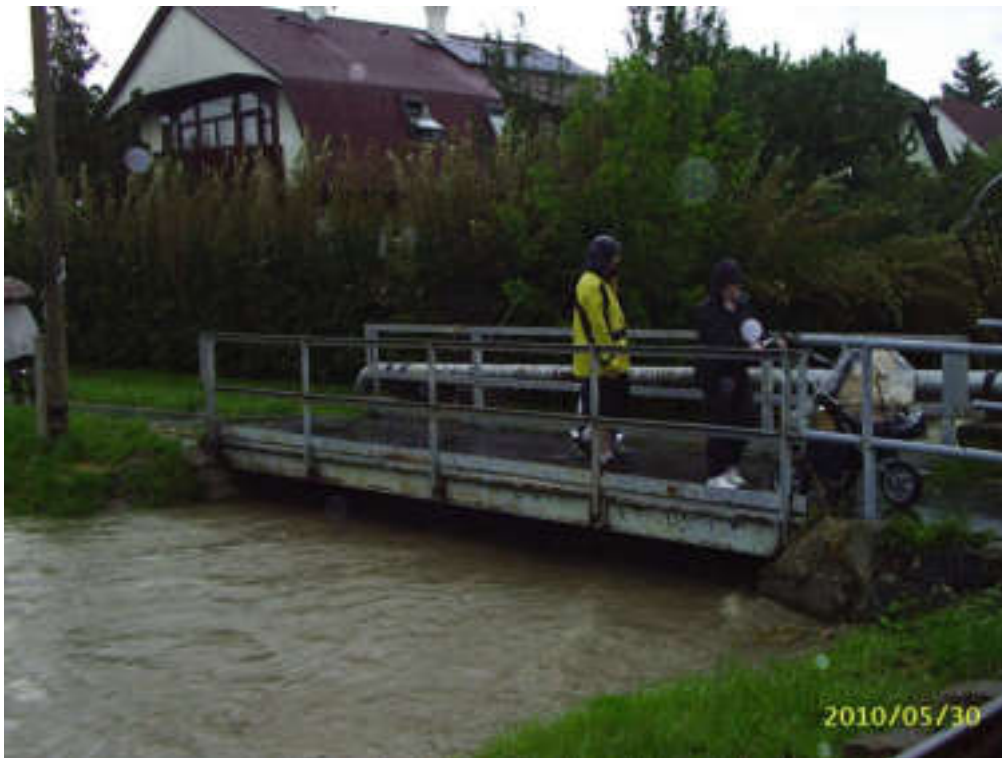
Gyaloghíd és közműkeresztezés a Korompai utca magasságában (Híd utca) (forrás: FCSM ZRt.)
