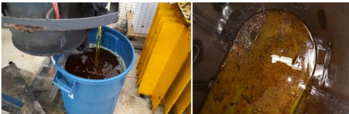
Figura 2.13. Extracción del aceite del transformador bajo prueba.
