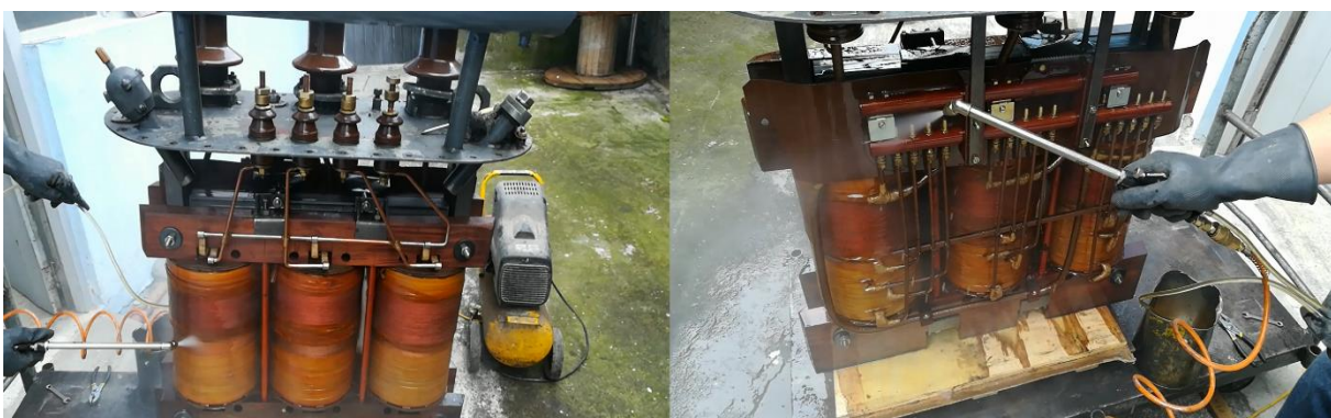
Figura 2.16. Lavado del conjunto núcleo-bobinas.
