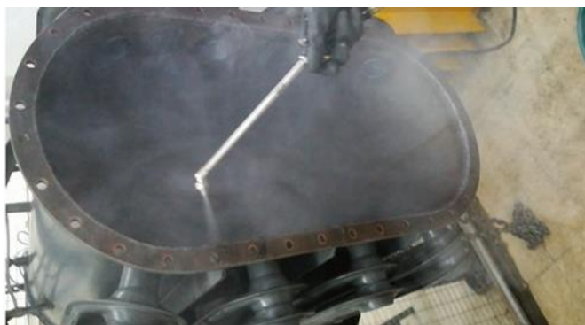
Figura 2.15. Lavado del tanque y limpieza de impurezas sobrantes.
