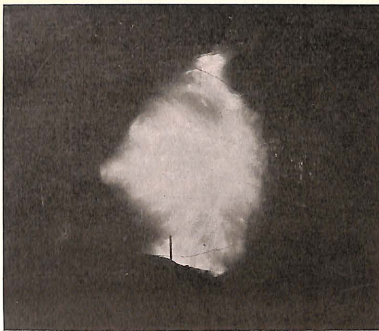
Photographie n° 2. — 6 cartouches de dynamite-gomme tirées au mortier d'acier. — Pas de bourrage extérieur.
