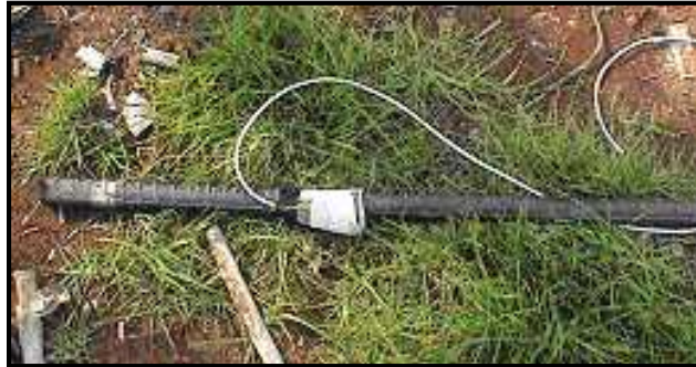
Figura 5-2 Cebado Inelectrico. Fuente: Grupo MARTE ESING.
