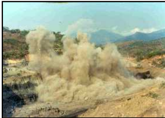
Figura 3-9 Medidas de seguridad con explosivos. Fuente: Grupo MARTE ESING.
