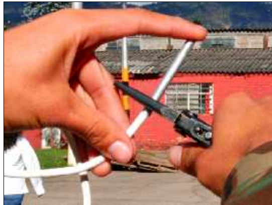
Figura 3-1 Medidas de seguridad con explosivos. Fuente: Grupo MARTE ESING.
