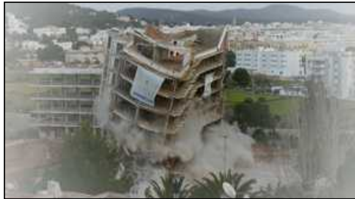
Figura 1-21 uso de explosivos en demoliciones. Fuente: Voladuras y Demoliciones
