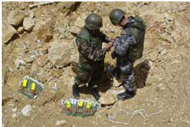
Figura 3-7 Medidas de seguridad con explosivos. Fuente: Grupo MARTE ESING.
