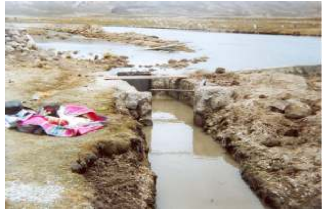
Bocatoma Casablanca, Chalhuanca, Caylloma.
