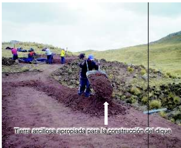
Colocación de tierra por capas.
