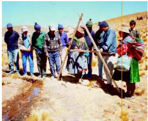
Realizando la nivelación y trazo.
