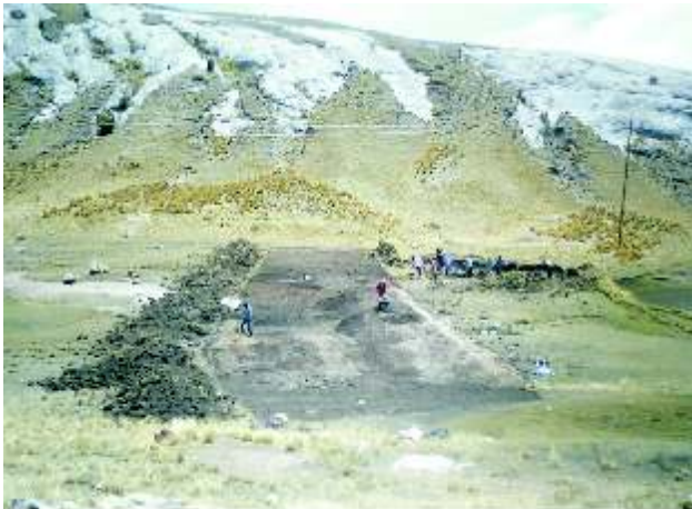
Limpieza de área de construcción.
