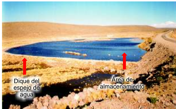
Estructura semicircular del espejo de agua Capillani, Toccra, Cayloma.
