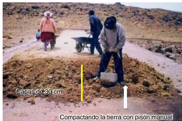
Compactación con pisón.
