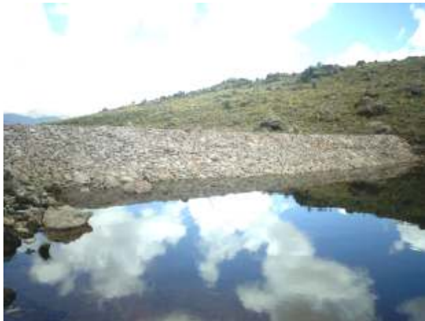
Cara protegida con piedra.
