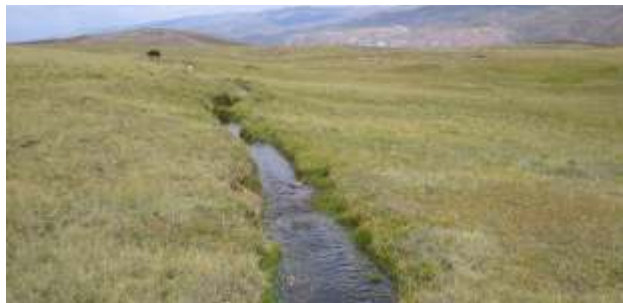
Canal protegido con gramíneas.
