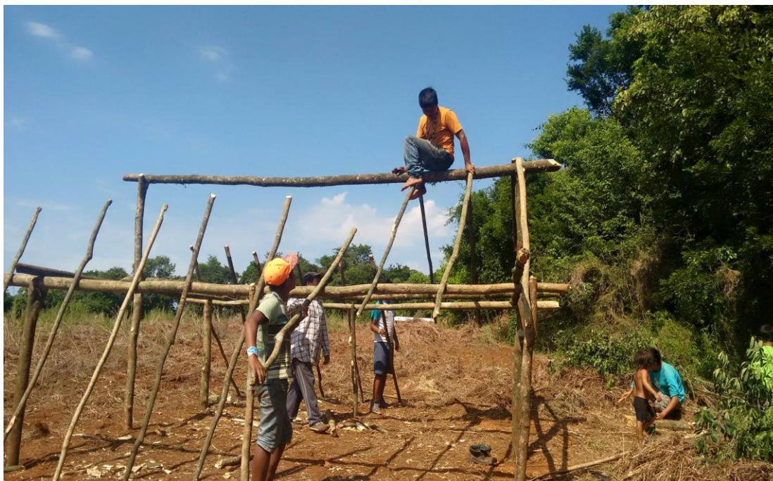
Figura 45: Construção de moradia
