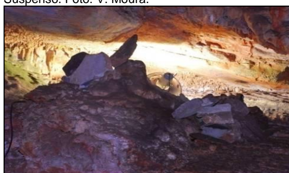
D – Anteparo de blocos instalados sobre espeleotema, com eficiência no rebatimento da iluminação, e causando impacto estético sobre o espeleotema. Foto: V. Moura.
