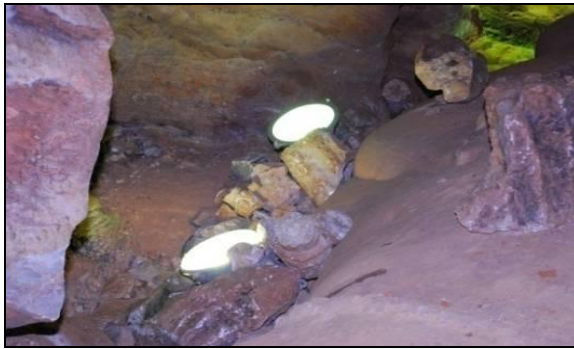
C – Acúmulo proposital de blocos para ocultar fiação elétrica. Local: Próximo à entrada do Conduto da Cobra. Foto: V. Moura.
