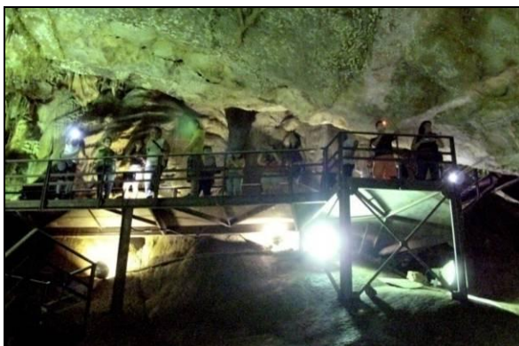
A – Exemplo de refletores mal direcionados, iluminando a estrutura da passarela, enfatizando e aumentando o impacto visual desta e causando ofuscamento nos visitantes. Foto: V. Moura.
