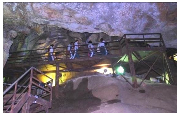
B – Exemplo de trecho da passarela, com passagem alta, considerado como de alto risco. Local da foto: próximo ao Lago Suspenso (Foto: V. Moura)
