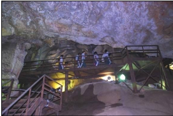
A – Vista de trecho da passarela com passagem a grande altura, onde a proteção do guarda-corpo é mais necessária. Foto: V. Moura.
