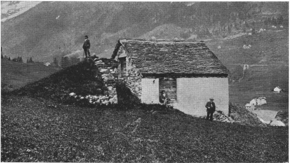
Abb. 76. Primitive Spaltecke zum Schutze einer Almhütte
