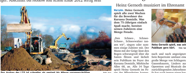
Der Ausbau der L33 ist schneller als geplant bis Hönow vorangeschritten.
