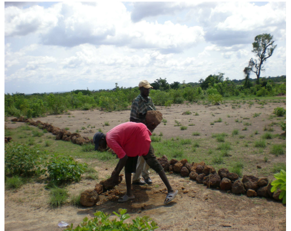
Construction de cordon pierreux
