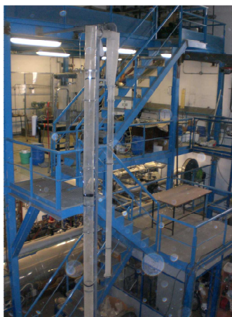
Foto 15. Vista desde arriba del reactor
