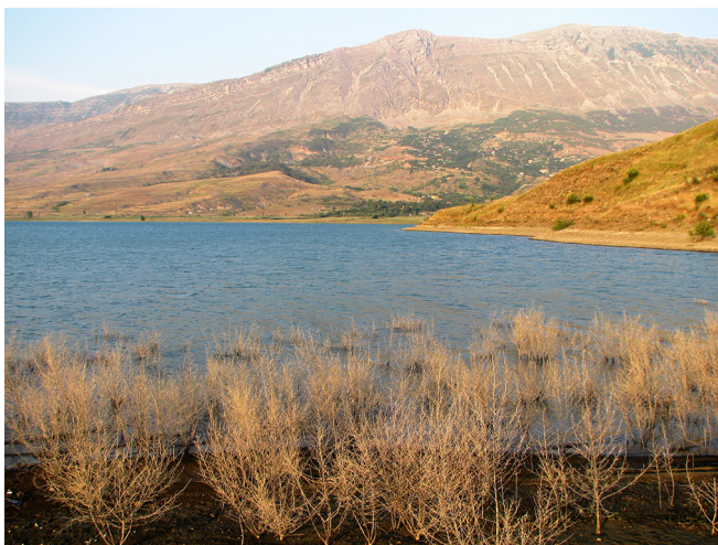
Fig. 5: Gjirokastrë district, Libohovë, water reservoir (dam) bank
